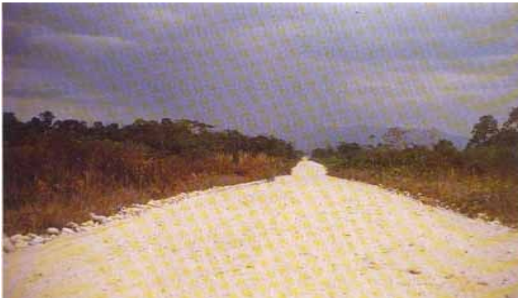
Carretera en construcción que va hacia La Macarena, Meta. Foto, : Femando Urbina
