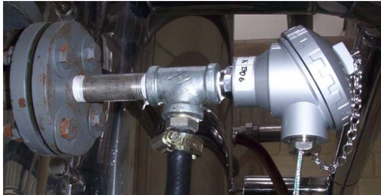
Figura 8.1: Termocupla instalada
