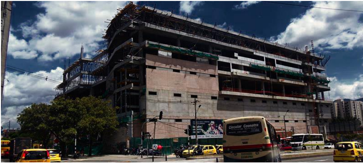
Figura 4. CE3: Construcción Centro Comercial Aventura
