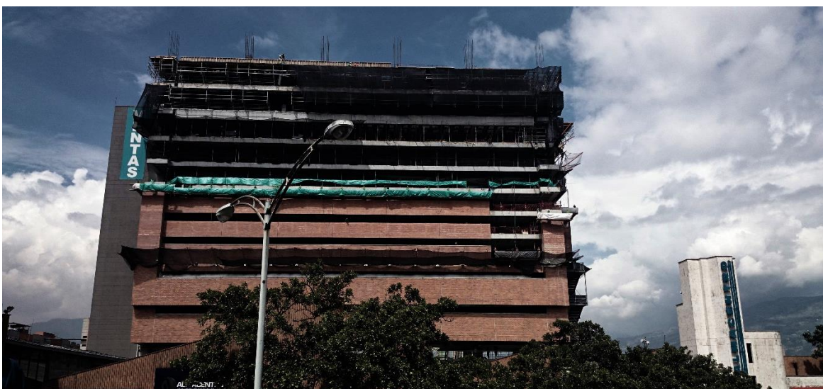
Figura 2. CE1: Construcción del centro comercial Almacentro Etapa 2
