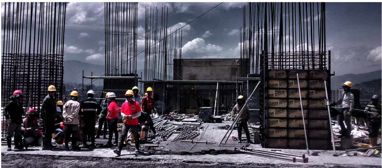
Figura 5. Trabajadores de la construcción durante el encofrado de columnas.
