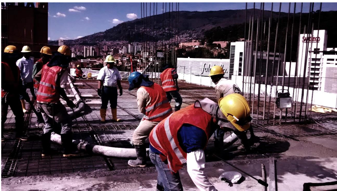
Figura 24. Trabajadores de la construcción durante el vaciado de una losa.
