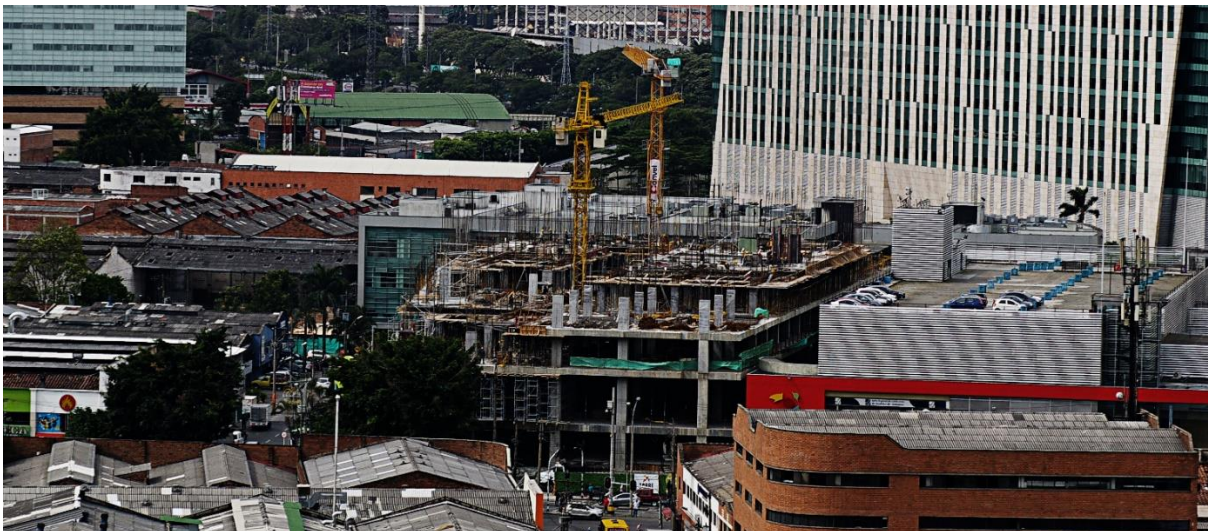
Figura 3: CE2: Ampliación Centro Comercial Punto Clave
