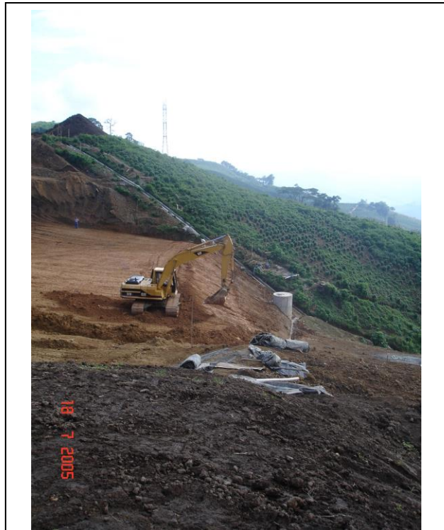
Figura 1.1 Los problemas vinculados con la construcción de un terraplén incluyen el manejo de aguas superficiales y subsuperficiales, de taludes, de estructuras de contención, la estabilidad volumétrica del suelo, el tratamiento de cauces y el establecimiento de coberturas vegetales. (Fotografía. Carlos E. Escobar P.)
