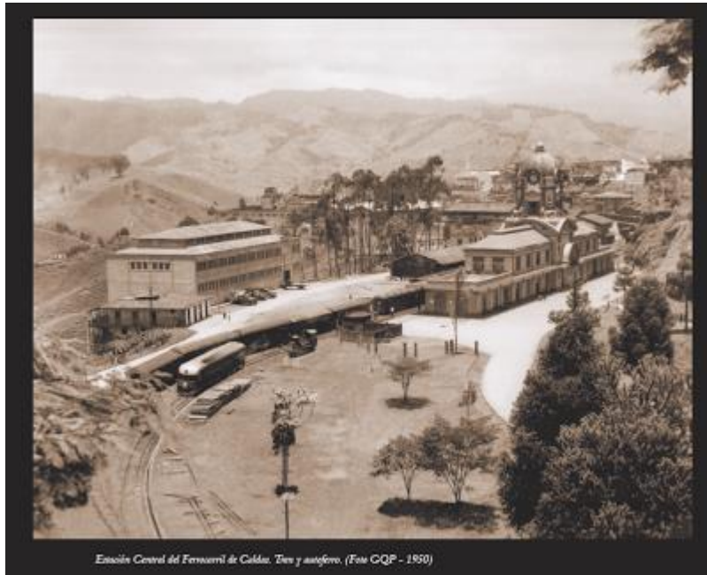
Imagen: Estación Manizales – SMP, Manizales
