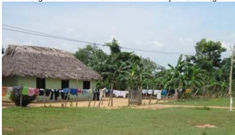
Fotografía No 22. Vivienda rural en La Mejia – San Jorge
