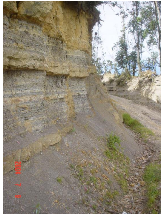
Figura 3.13 Secado de un talud vertical por déficit hídrico y la falta de protección con vegetación por la imposibilidad de su arraigo y establecimiento (Carlos E Escobar P)
