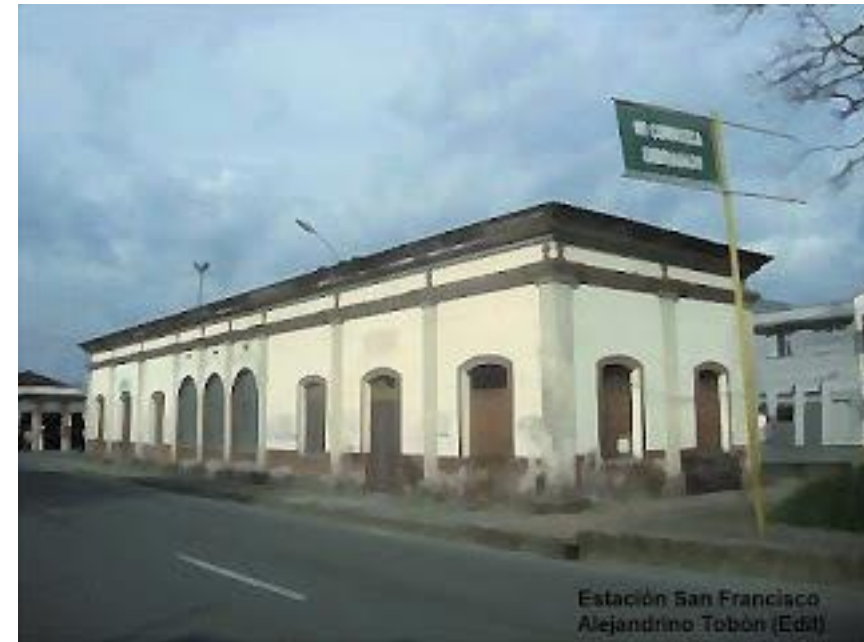
Imagen, Estación San Francisco del Ferrocarril de Caldas, en Chinchiná.
