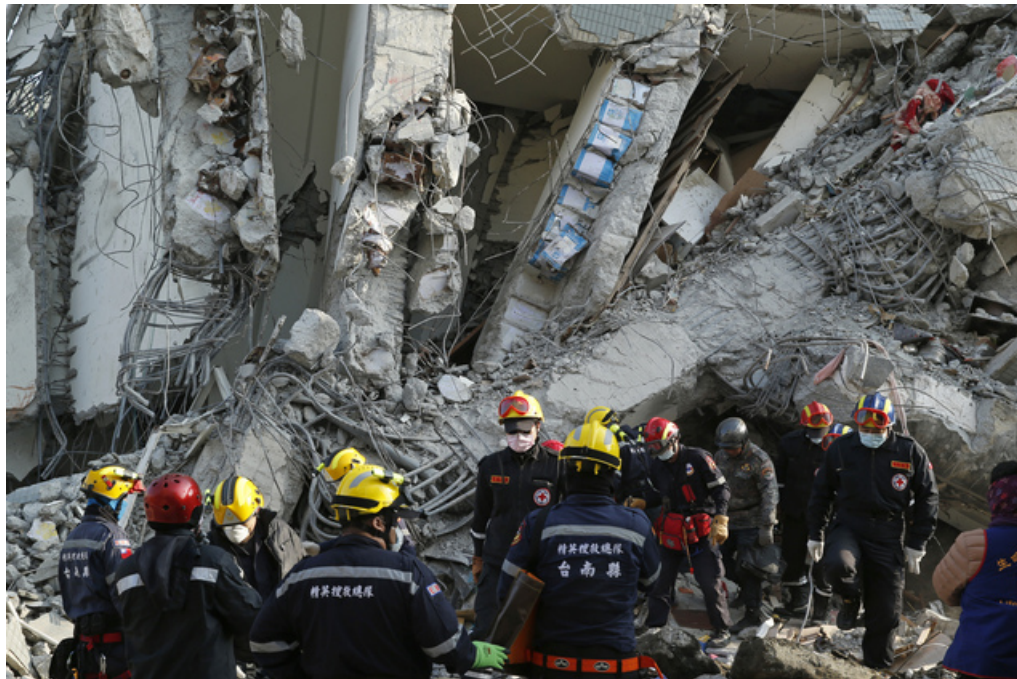
Figura 4.1: Sismo de Taiwan. 2016 [Santana, 2016]
