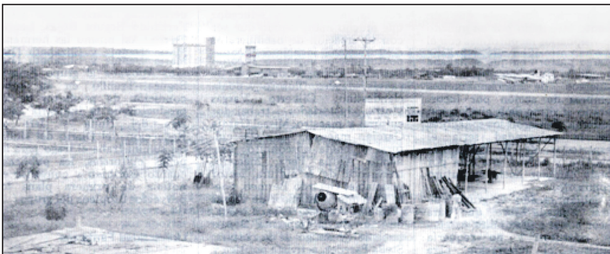
Zona donde empieza la construcción de la Universidad Surcolombiana, que corresponde a la ubicación actual.
