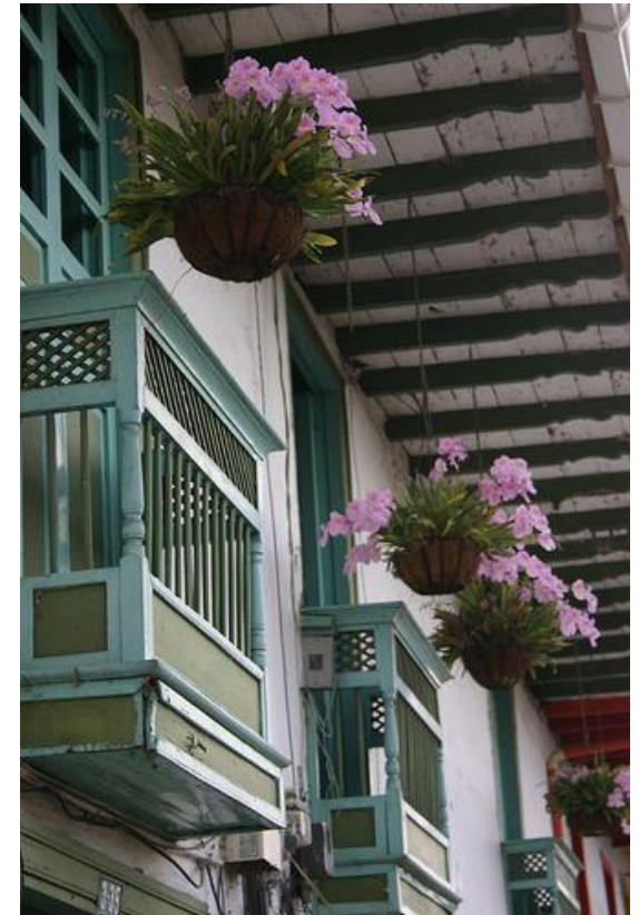
Imagen: bahareque, valiosa arquitectura vernácula del PCC, en constructoracamu.com
