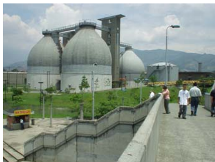
Imagen 24. Planta de tratamiento de aguas de San Fernando. Archivo de fotografía. Noviembre 2004.
