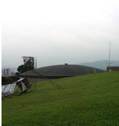
Imagen 18. Tanque en la Planta de tratamiento de Villahermosa. Archivo de fotografía. Junio 2006
