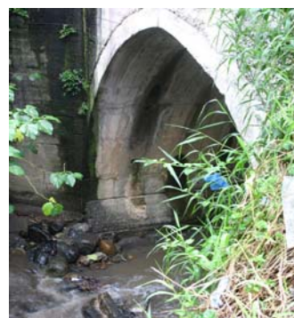
Imagen 1. Bóveda Quebrada Santa Elena, a la altura del puente de la toma. Archivo fotográfico. Junio 2006
