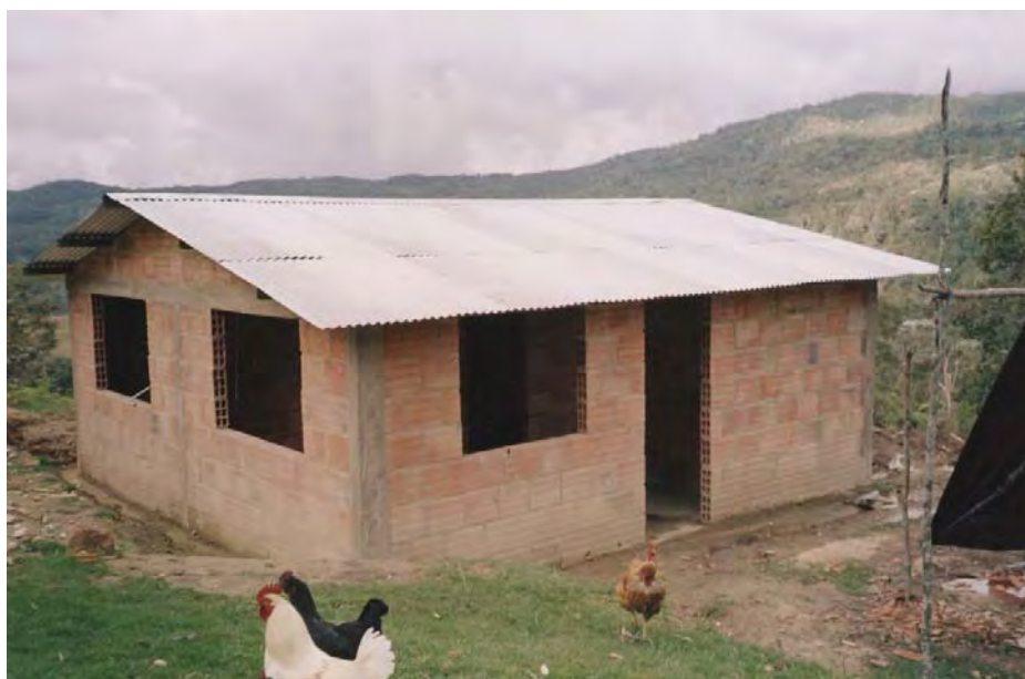
Foto 38. Casa elaborada con los subsidios estatales. 8 de noviembre 2007.
