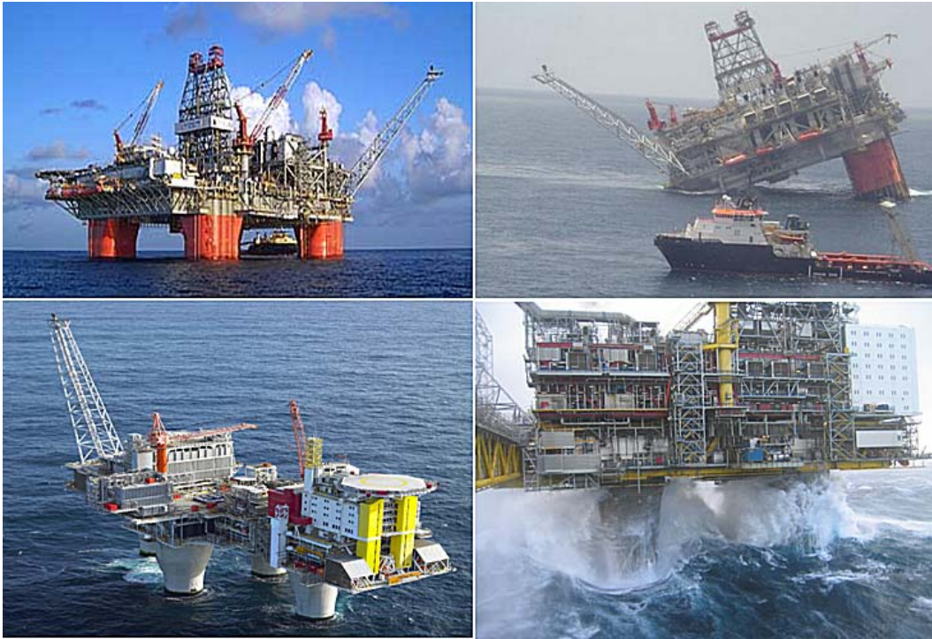
Figura 1.1: Daños causados por eventos naturales. Superior izquierda: plataforma petrolera Thunderhorse , Golfo de México USA. Superior derecha: fallo estructural de la plataforma Thunderhorse después del paso del huracán Dennis (2005). Inferior izquierda: plataforma petrolera Heidrun , Mar del norte, Noruega. Inferior derecha: plataforma Heidrun después del paso del huracán Oseberg (2007).
