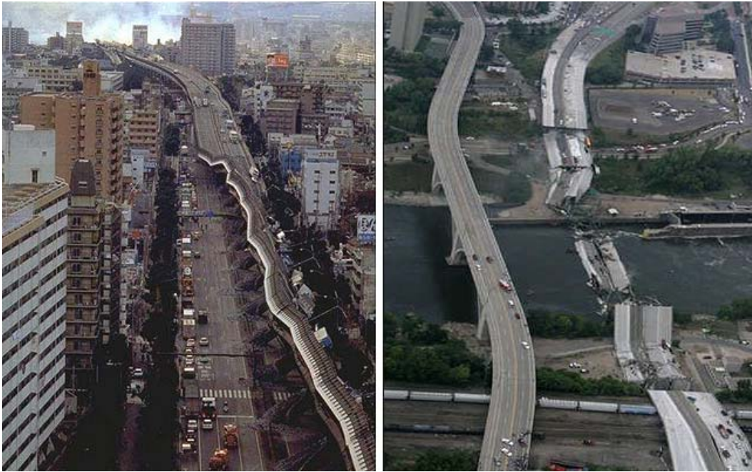
Figura 1.3: Izquierda: Autopista Hanshin , luego del terremoto de Kobe (Japón, 1995). Derecha: Puente I-35W, luego del colapso debido a la carga vehicular (USA, 2007) (Fuente ABC News).
