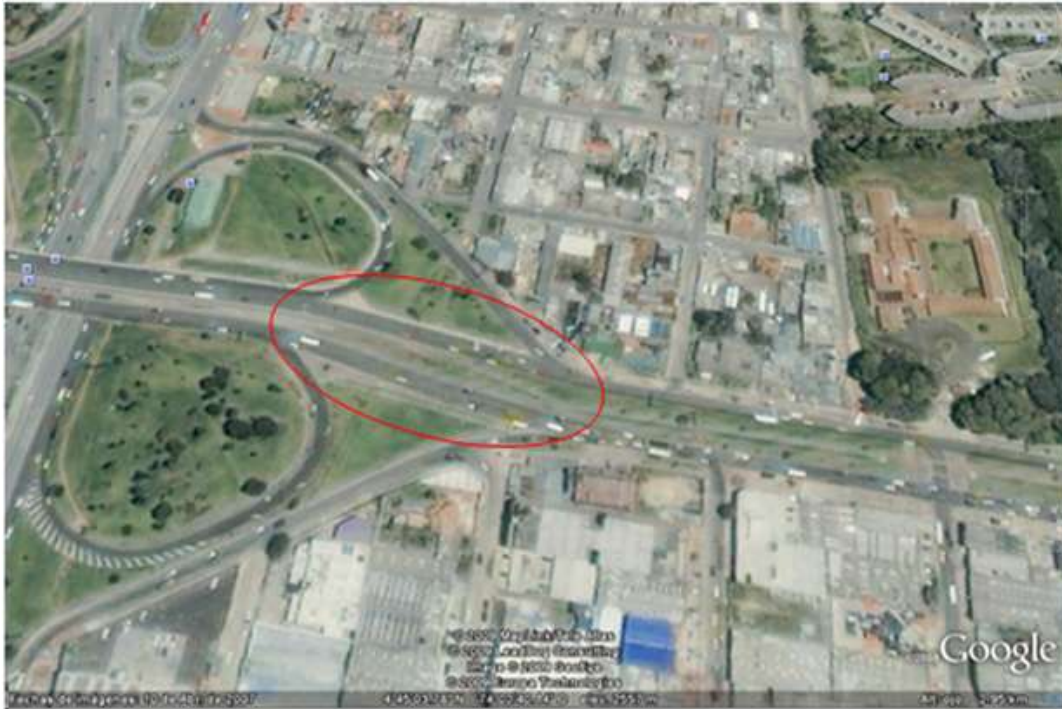
Figura 15 Localización del tramo de prueba en el perímetro urbano de la ciudad de Bogotá.
