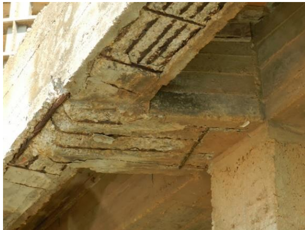
Figura 10. Estructura cercana al mar bajo la acción de los iones de cloruro.
