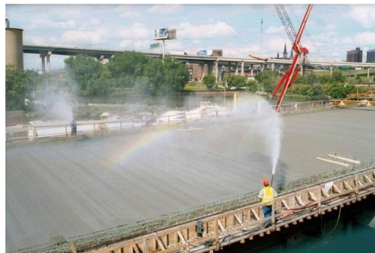
Figura 5. Agua para el curado del concreto.
