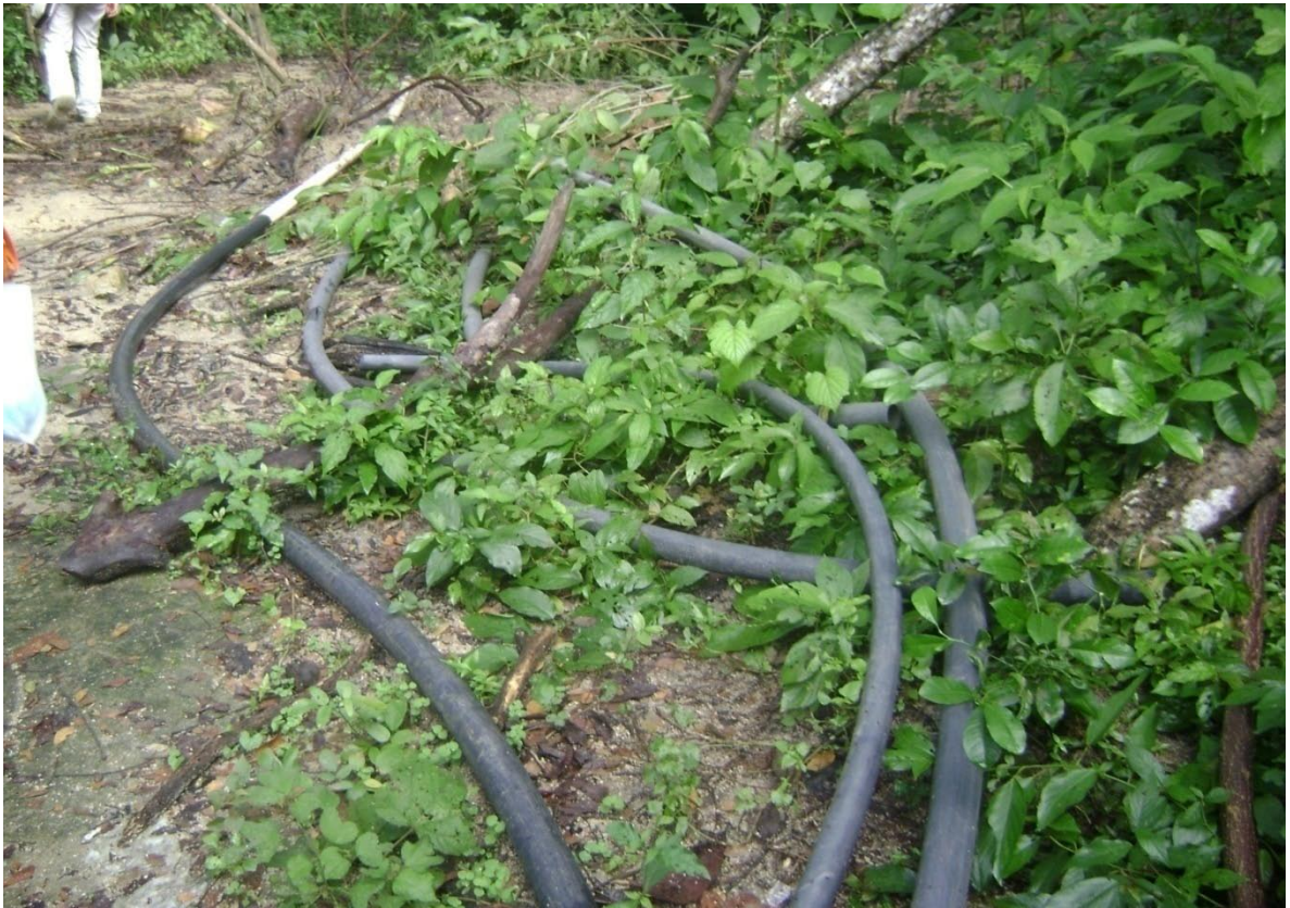
Figura 35: Infraestructura portátil, manguera en invierno. Fuente: Lorena Aja Eslava, 2009.
