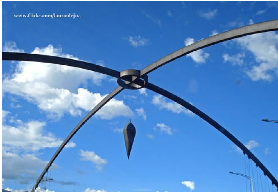
Figura 3. Capa de pátina formada en estructura de acero patinable ubicada en Punto Cero en Medellín
