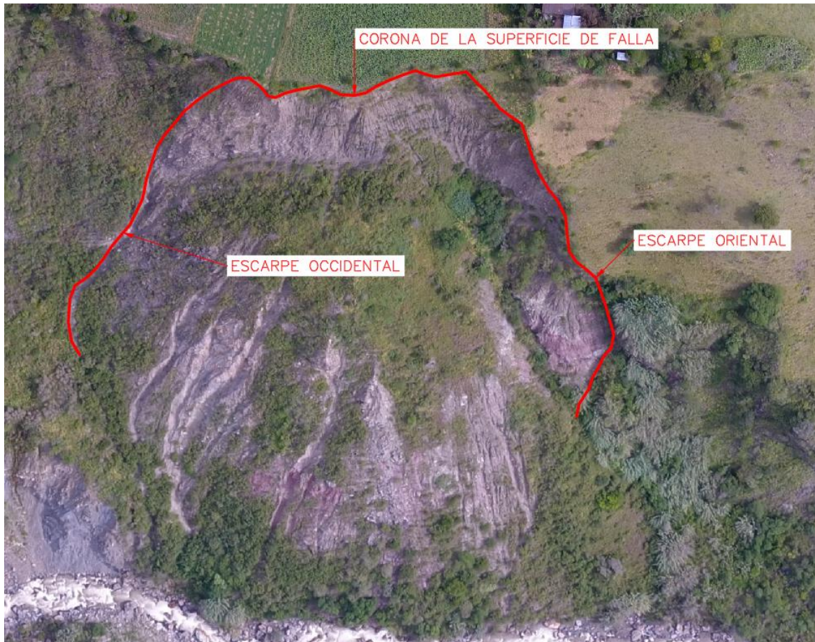
Figura 3-3. Identificación de las partes principales de la superficie de falla. Evento Z6_20_5 (Carcasí, Santander)
