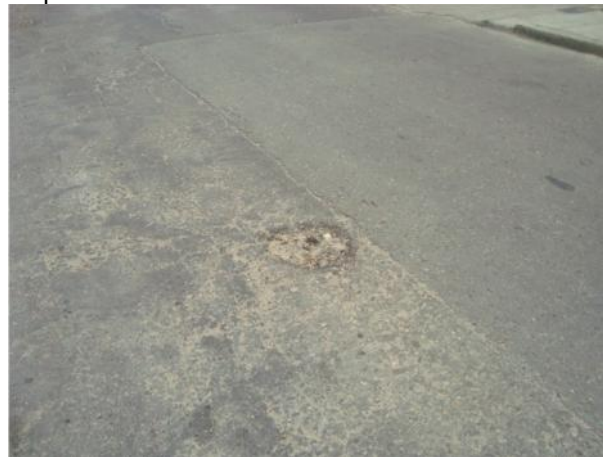
Foto 4-6: Ojos de pescado en pavimento flexible.
