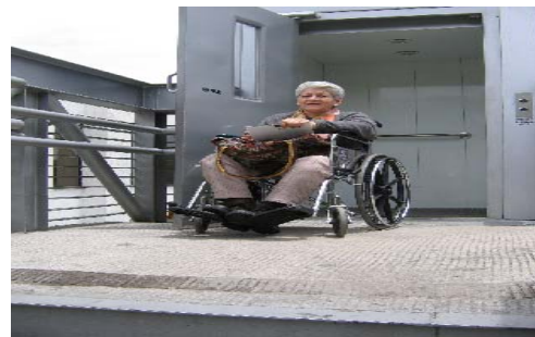
d) Espacios reducidos en ascensores
