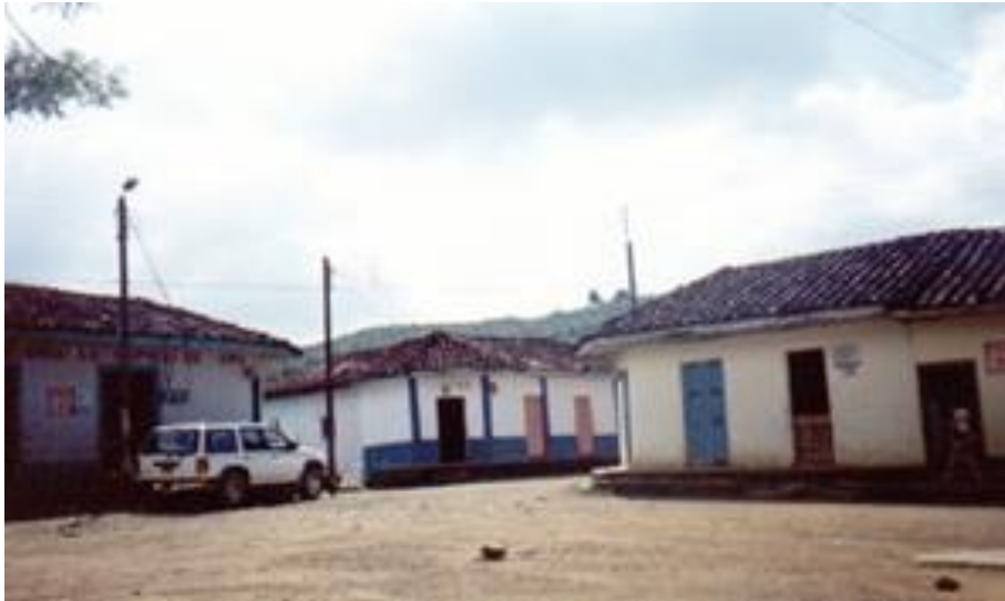
Fotos 3-1 y 3-2 Estado Actual de las Viviendas
