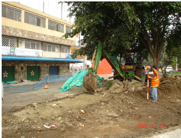
Figura 22. Isla canalizadora recién comenzada la remodelación
