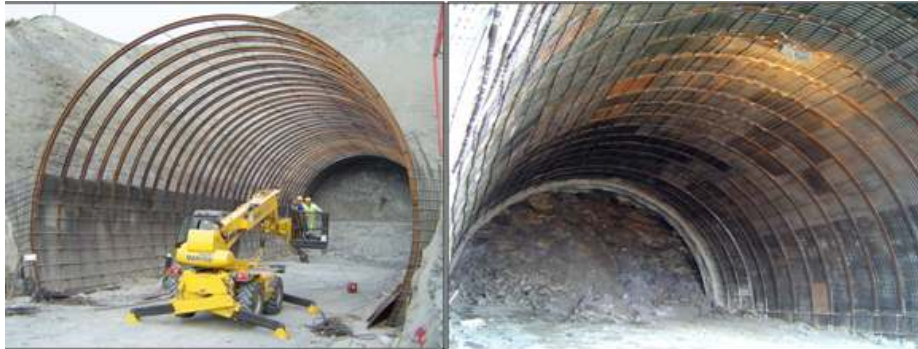
Figura 1-4. Arcos metálicos o costillares.
