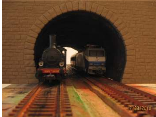
Figura 1-3. Túnel con sección transversal en forma de herradura.
