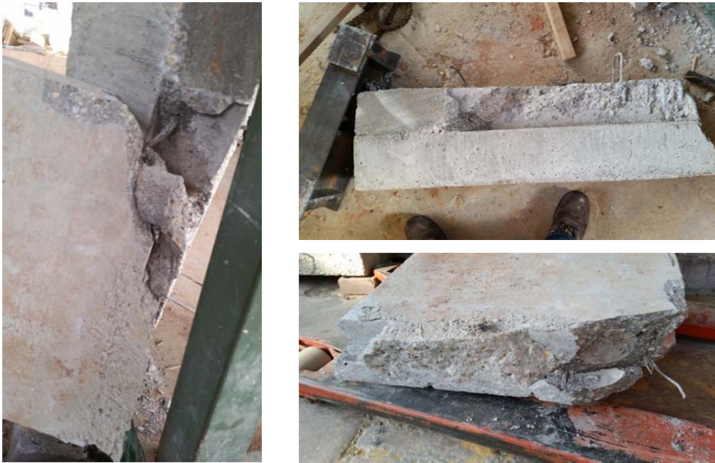
Figura 41. Detalles de falla probeta 1.1
