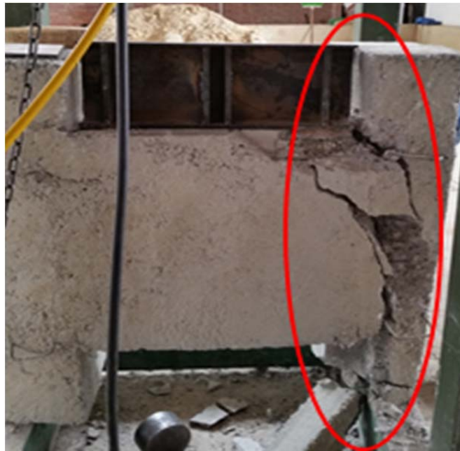
Figura 56. Modo de falla de la probeta 3.1
