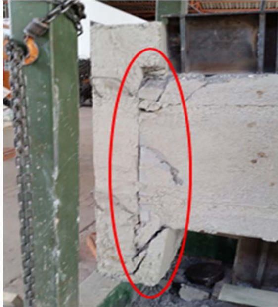
Figura 55. Modo de falla de la probeta 2.4
