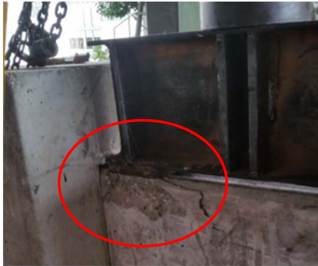
Figura 53. Aplastamiento en zona de aplicación de carga
