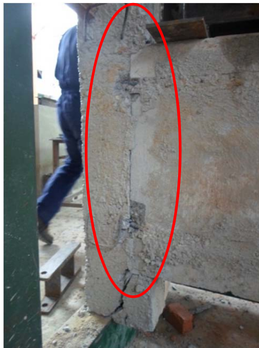
Figura 50. Modo de falla de la probeta 2.1
