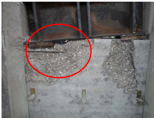
Figura 44. Aporte del tendón de pre esfuerzo de la losa alveolar al ensayo
