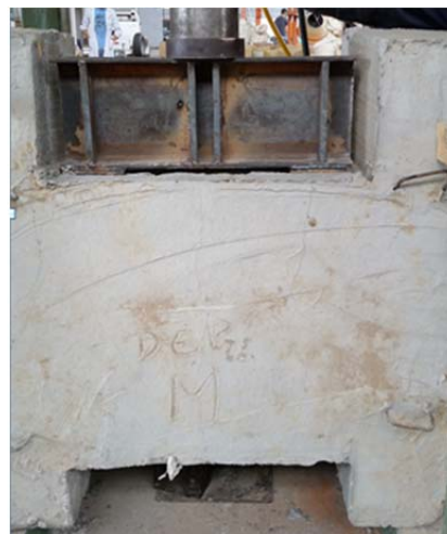
Figura 60. Agrietamiento en la junta, evidencia de falla por corte en la probeta 3.4
