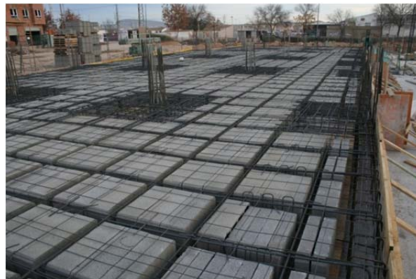
Figura 4 Entrepiso en losa aligerada con poliestireno (Fuente: Centro de Información, Innovación y Recursos Educativos de Elda)
