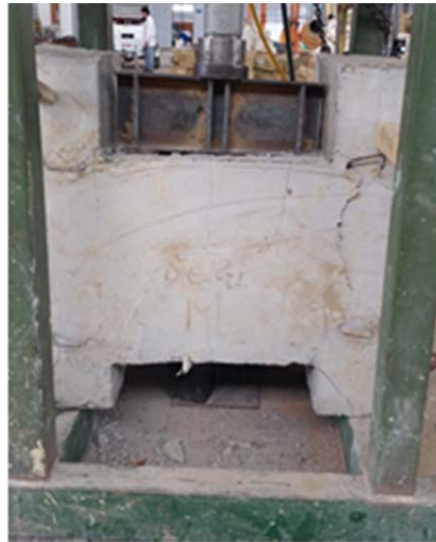
Figura 59. Agrietamiento en la junta, evidencia de falla por corte en la probeta 3.3
