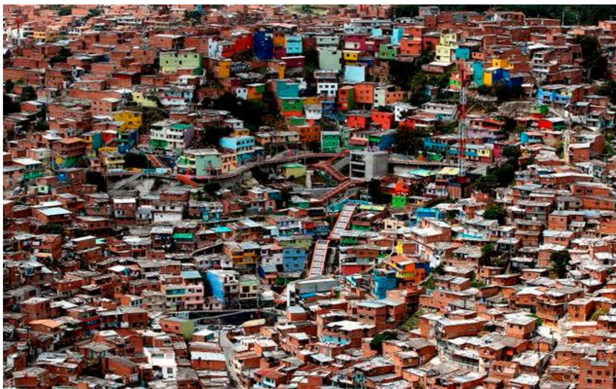
Figura 18. Panorámica escaleras eléctricas
