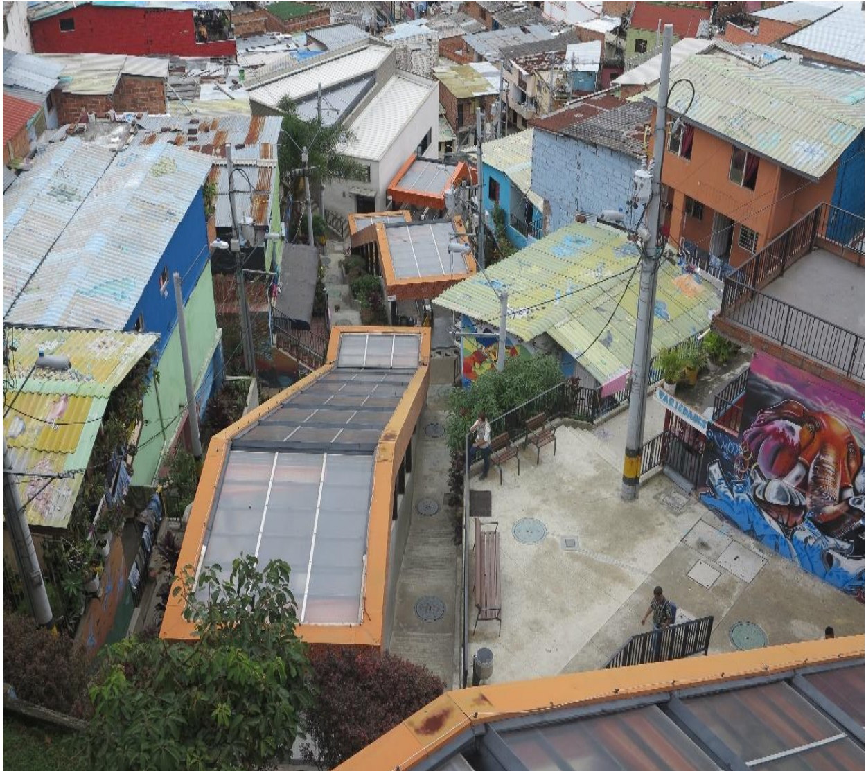
Figura 17. Escaleras eléctricas comuna 13
