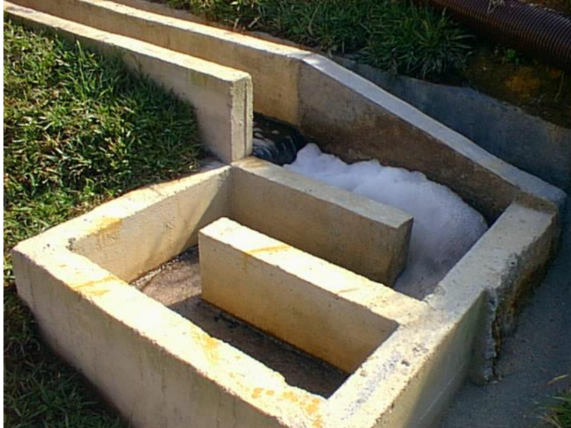
ESTRUCTURA ENTRE TANQUE REGULADOR Y REACTOR UASB
