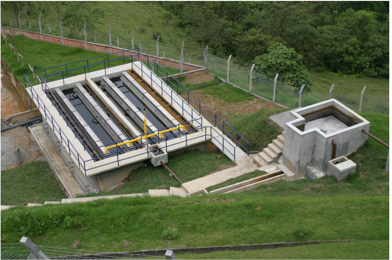
ESTRUCTURA ENTRE TANQUE REGULADOR Y REACTOR UASB
