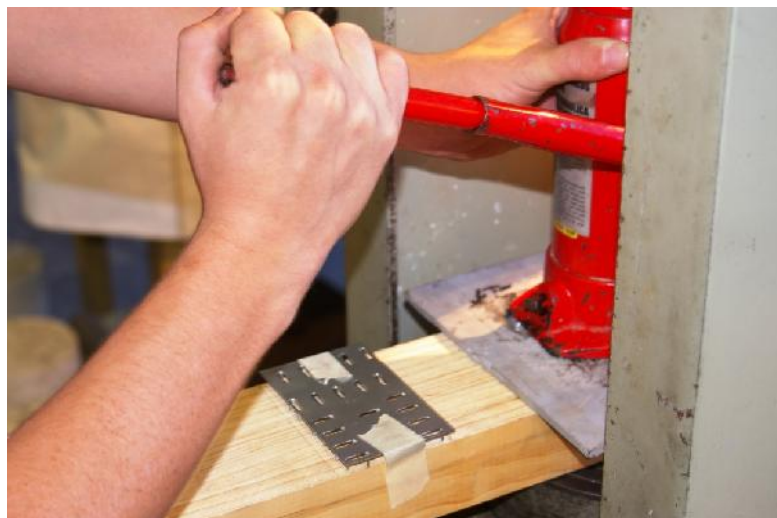
Figura 16: Instalación de pletinas metálicas dentadas en las caras laterales de las vigas de madera laminada Glulam
