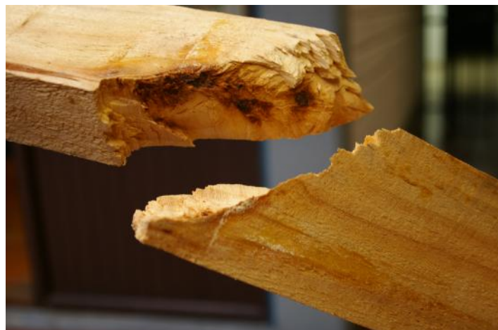
Figura 37: Ruptura de viga de madera maciza en zona con presencia de nudos
