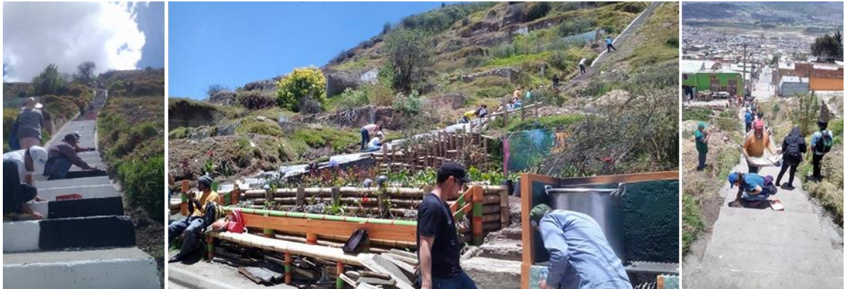
Figura 17. Obras de adecuación en ladera de alto riesgo, barrio Naciones Unidas. SDHY-CVP.
