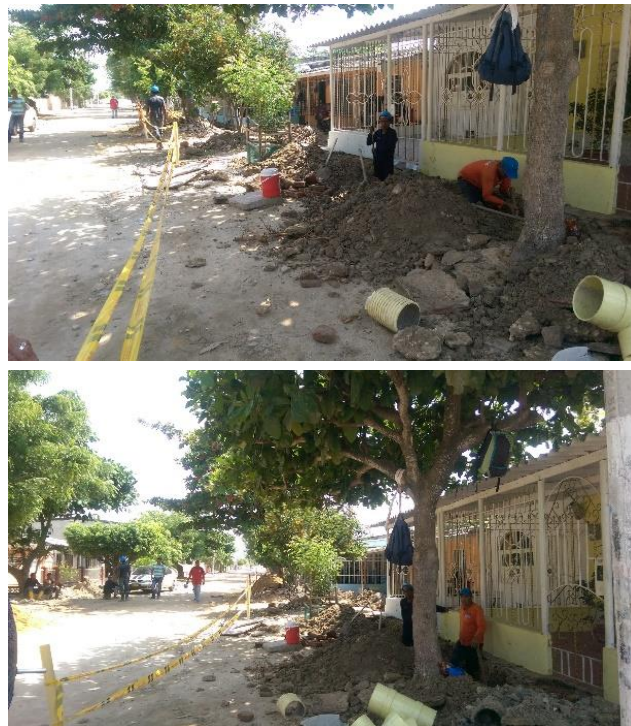
Figura 23. Eje Peatonal calle 12 en obra.
