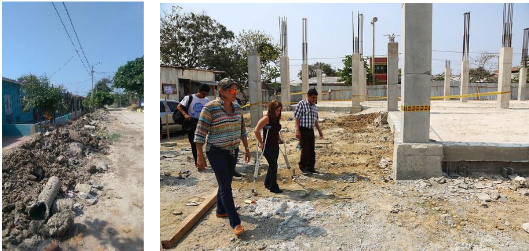
Figura 24. Obras CAMI La Luz.
