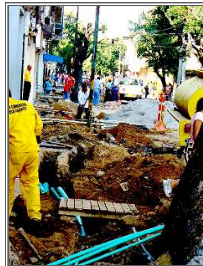
Figura 19. Construcción del Centro Comercial a cielo abierto. Publicado en Skyscrapercity
