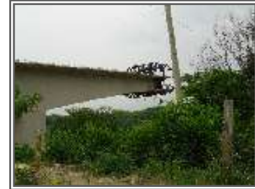
Figura 20. Obra inconclusa. Construcción del puente La Gazapa.
