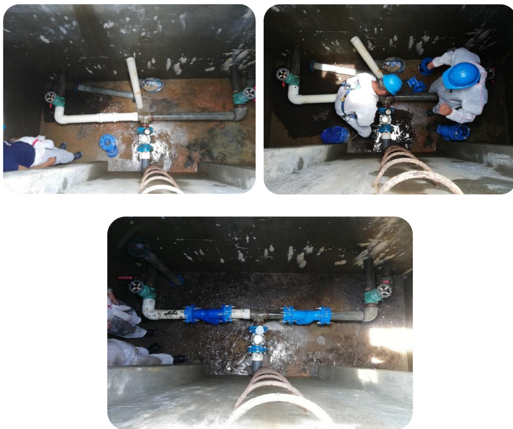
Ilustración 22: Instalación de macromedidor y filtros en el tanque Lomas (Elaboración propia, 2020)
