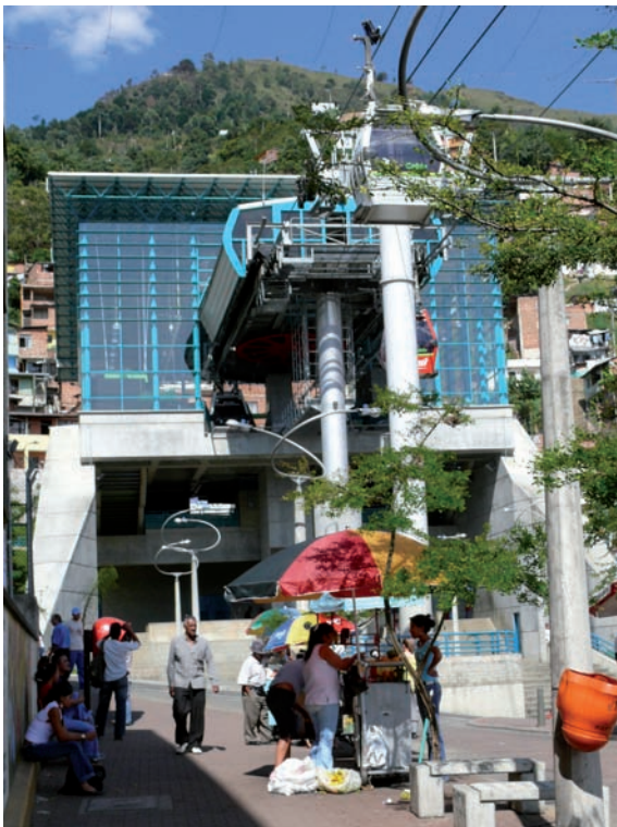
Metrocable. Estación Santodomingo, Fotografía de Luis Fernando González E., junio de 2007.
