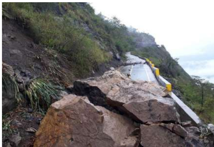
Fotografía 7. Bloque sobre la vía Barichara - Guane
