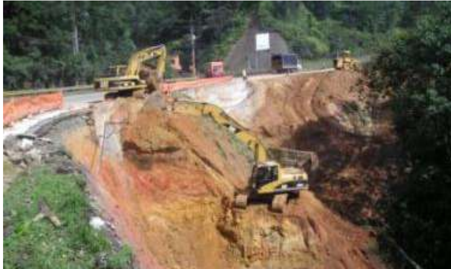
Fotografía 24. Excavación bajo condiciones de repaleo.
