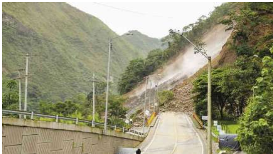
Fotografía 15. Zona de avalancha, kilómetro 46+200, municipio de Quetame (Cundinamarca) Fuente: Revista Semana. (2019).
