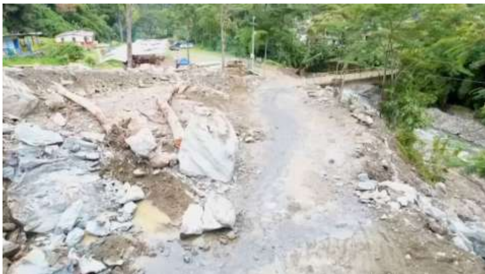
Fotografía 31. Bloque que obstruyen vía que comunica la ciudad de Ibagué con los municipios de Combeima y Villa Restrepo (Tolima) Fuente: El autor (2025)
