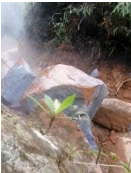
Fotografía 52. Resultados de la fragmentación del bloque de roca N. 01 municipio de San Luis Fuente: Voladura Demolición y Perforación 3JY (2022)
