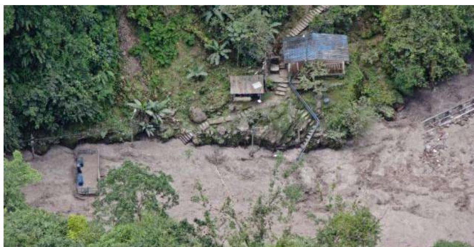
Fotografía 45. Bocatoma sepultada por barro Fuente: El Tiempo (2022)
