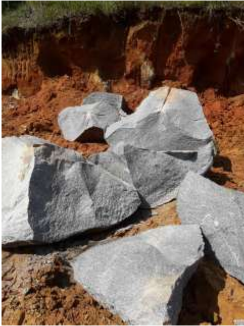
Fotografía 53. Resultados de la fragmentación del Bloque de roca N. 02 municipio de San Luis Fuente: Voladura Demolición y Perforación 3JY (2022)
