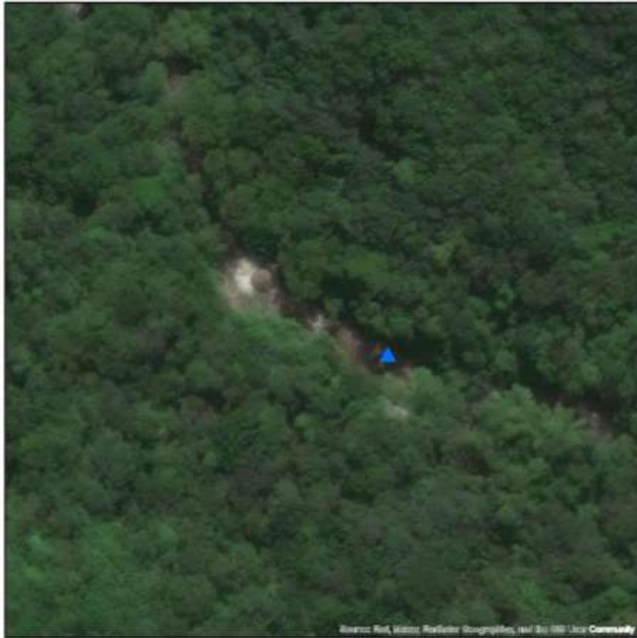
Imagen 31. Ubicación de bloques que obstruían el cauce y paso de agua a la bocatoma
