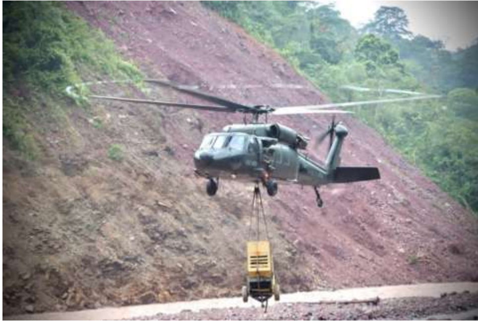
Fotografía 49. Transporte de plantas eléctricas requeridas para los trabajos técnicos Fuente: Ejército Nacional de Colombia. Escuela de Ingenieros Militares – ESING. (2017)
