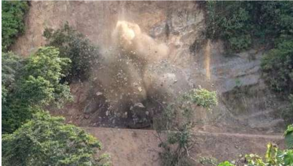
Fotografía 42. Voladura del bloque en vía secundaria sobre talud con alta pendiente Fuente: Ejército Nacional de Colombia. Escuela de Ingenieros Militares – ESING. (2022)
