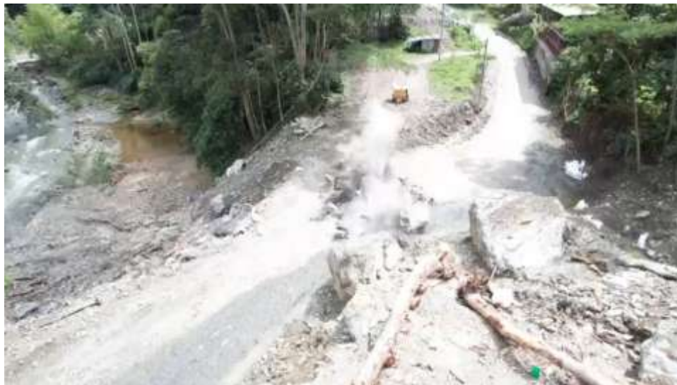
Fotografía 29. Momento de la detonación para fragmentar el 1.er bloque de roca Fuente: El autor (2025)
