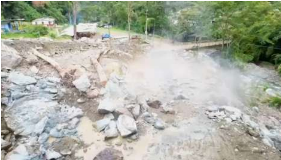
Fotografía 33. Resultado de la detonación, fragmentación del 2do bloque de roca Fuente: El autor (2025)
