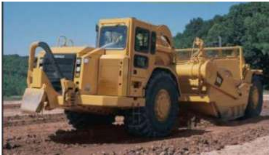
Fotografía 26. Excavación con Mototrailla
