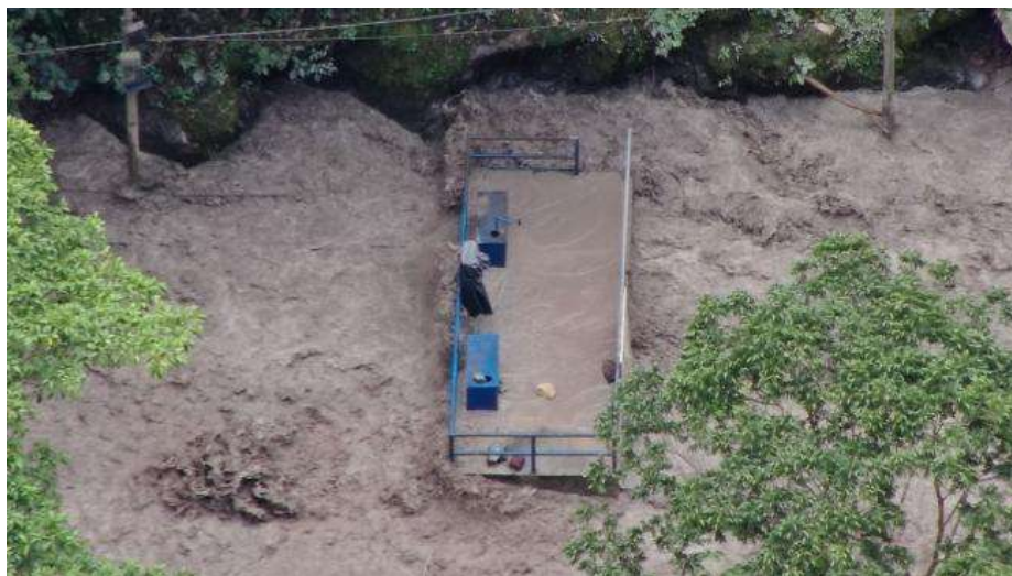
Fotografía 44. Creciente y afectación en la zona de bocatoma Fuente: El Tiempo (2022)
