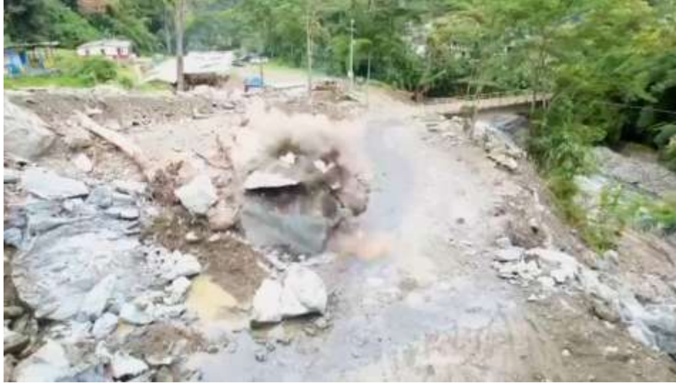
Fotografía 32. Momento de la detonación para fragmentar el 2.º bloque de roca Fuente: El autor (2025)
