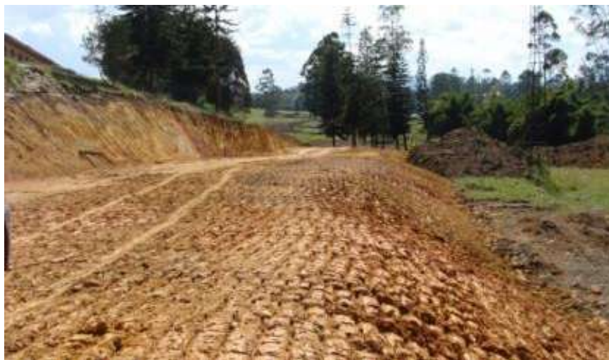
Fotografía 21. Corte y lleno Adyacente.
