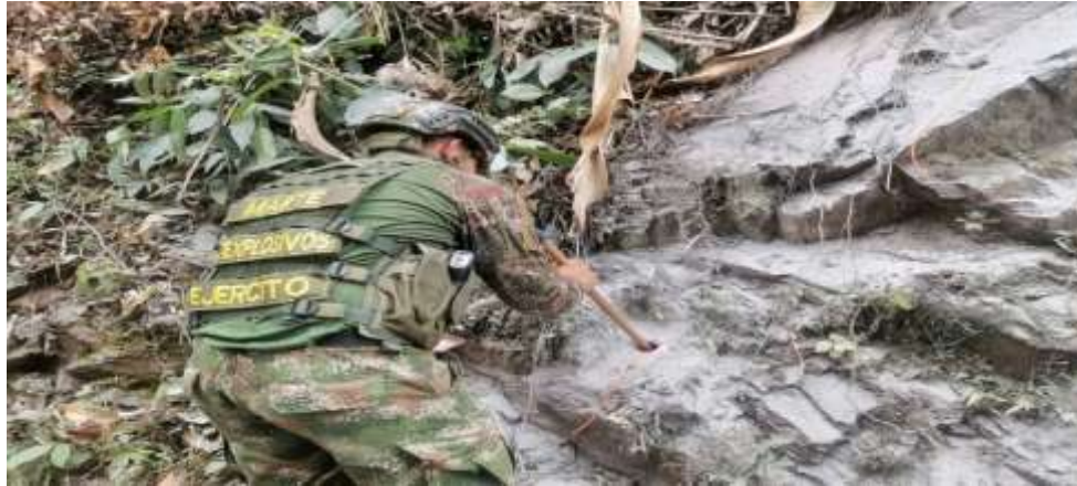
Fotografía 35. Proceso de carga y tacado de explosivo en bloque Fuente: Ejército Nacional de Colombia. Escuela de Ingenieros Militares – ESING. (2023)
