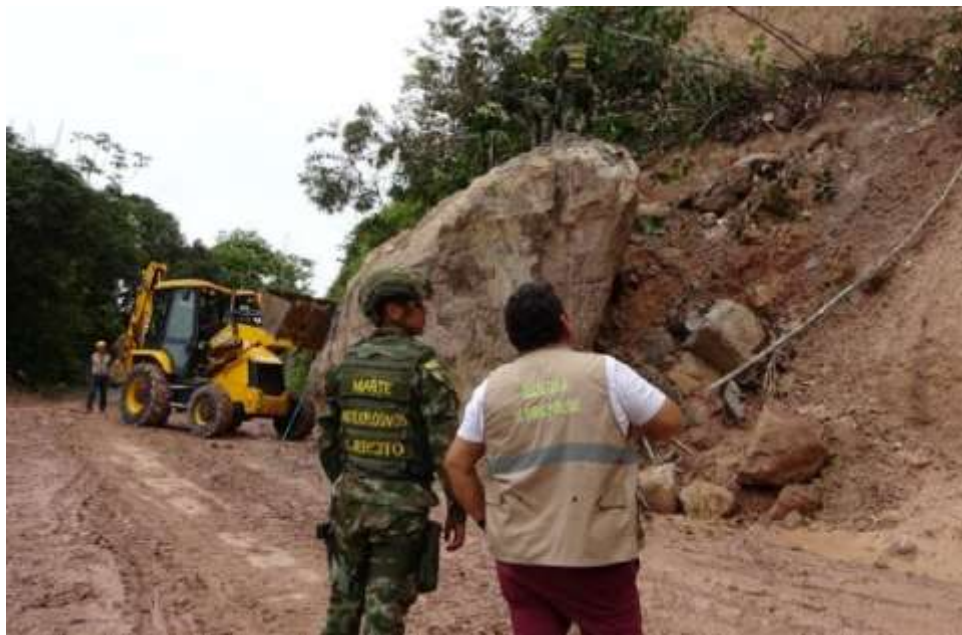
Fotografía 39. Proceso de inspección del área de voladura Fuente: Ejército Nacional de Colombia. Escuela de Ingenieros Militares – ESING. (2022)
