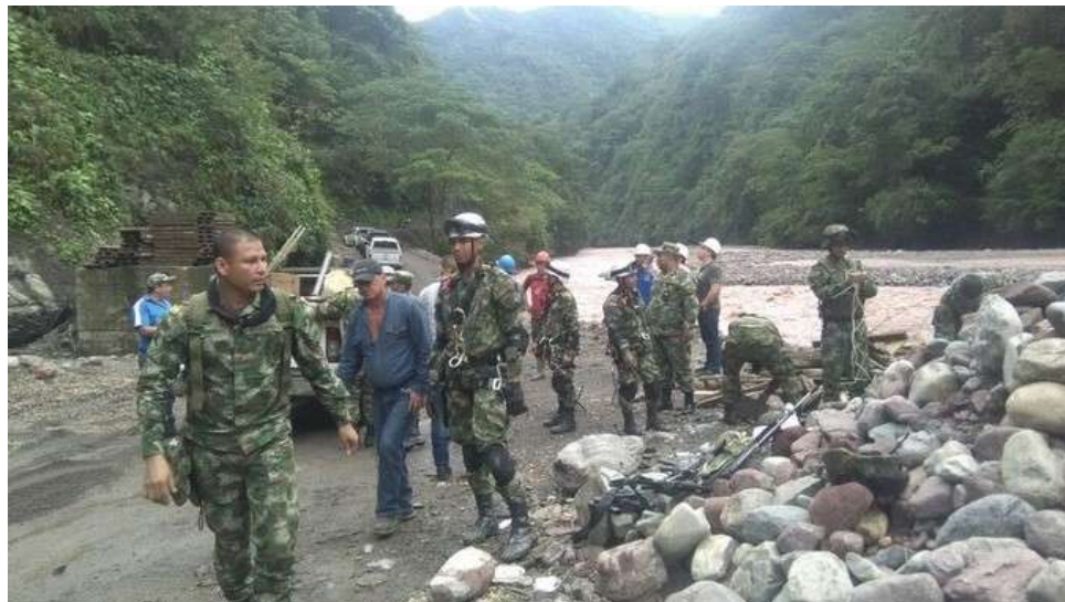
Fotografía 48. Proceso de amarre y corte de cordón detonante y ubicación de detonadores Fuente: Ejército Nacional de Colombia. Escuela de Ingenieros Militares – ESING. (2017)
