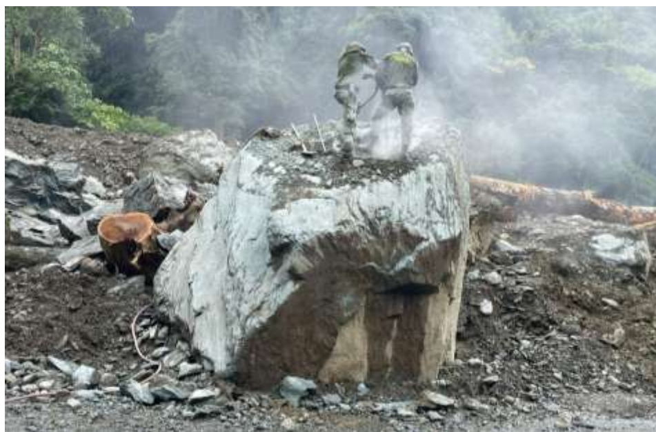
Fotografía 28. Perforación de barreno en uno de los bloques de roca Fuente: Ejército Nacional de Colombia. Escuela de Ingenieros Militares – ESING. (2023)
