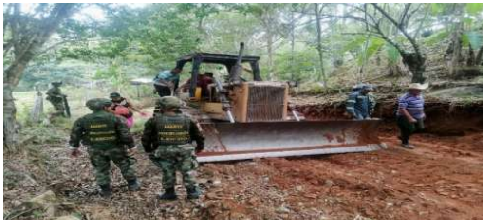
Fotografía 38. Manejo de escombros, proceso de reafirmado en la vía
