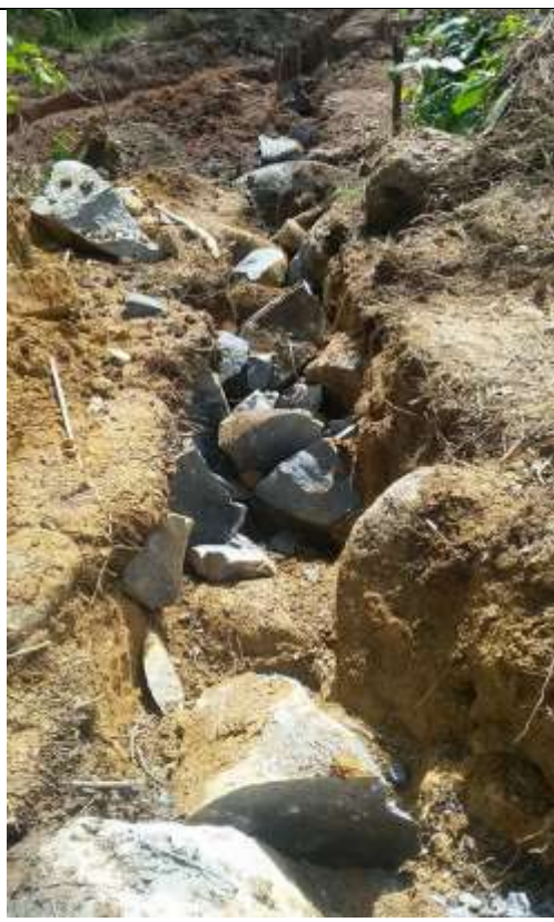
Fotografía 57. Zanja con bloque de tonalita fragmentados Fuente: Voladura Demolición y Perforación 3JY (2017)
