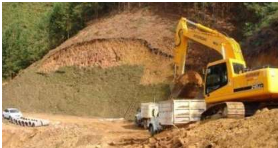
Fotografía 23. Volqueta al mismo nivel de sustentación de la excavadora.
