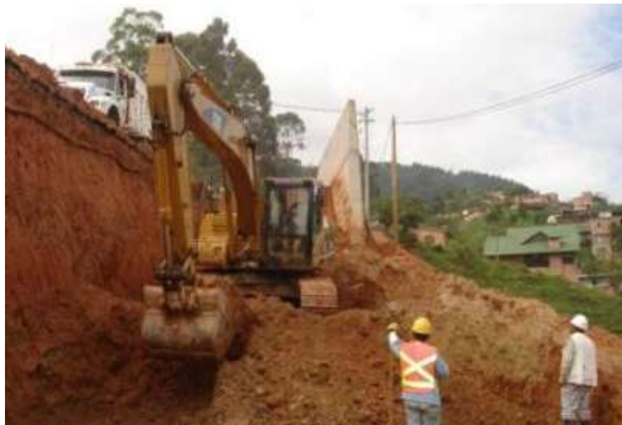
Fotografía 25. Volqueta está por encima del nivel de sustentación
