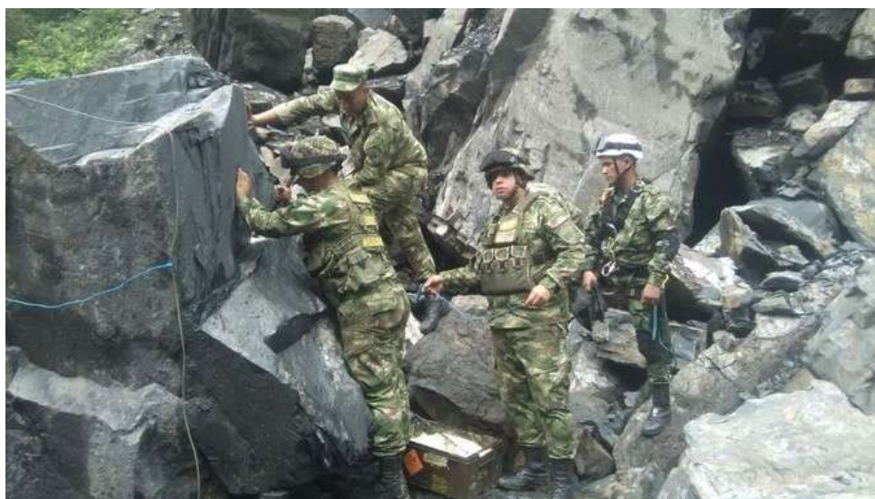
Fotografía 47. Inspección de bloque antes de la voladura
