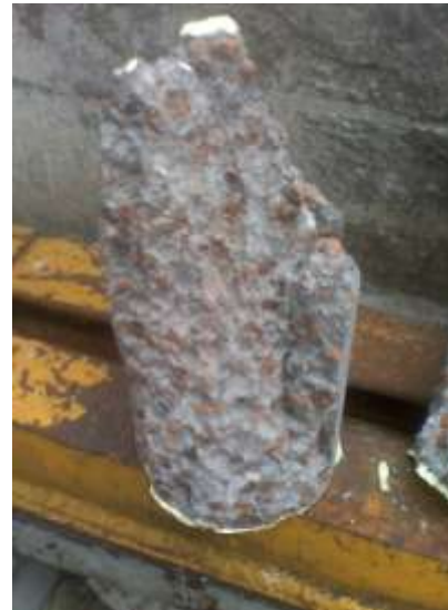
Figura 5.16. Esquema de la falla interior del concreto con ALISUR.
