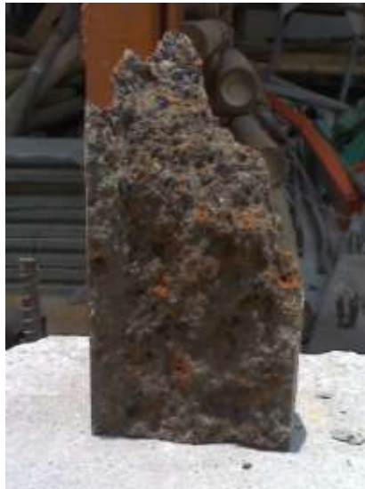
Figura 5.15. Esquema de la falla interior del concreto con ALIVEN.
