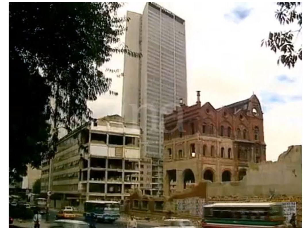
Proceso de demolición edificios adosados a las Falcas. Fotografía tomada de fragmento filmico del Instituto Nacional del Audiovisual de Francia (INA).
