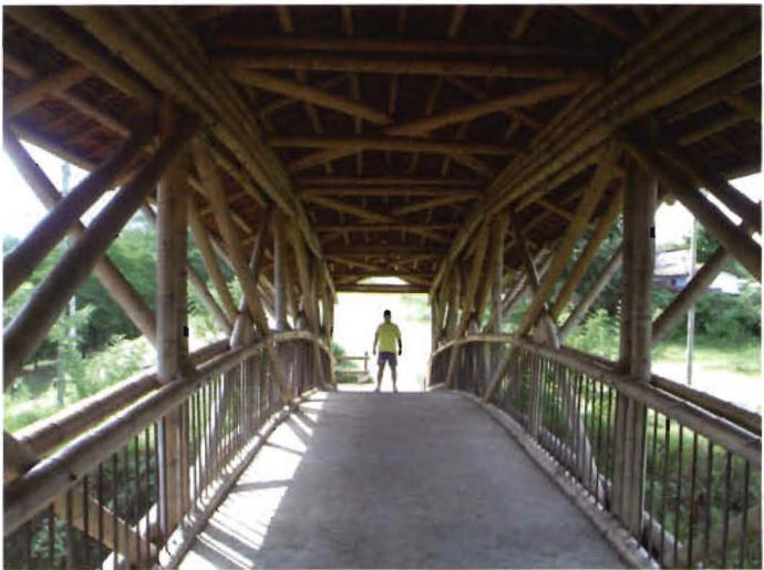
Figura 53. Puente en guadua (Santafé de Antioquia. Diseño de JÖRG STAMM)
