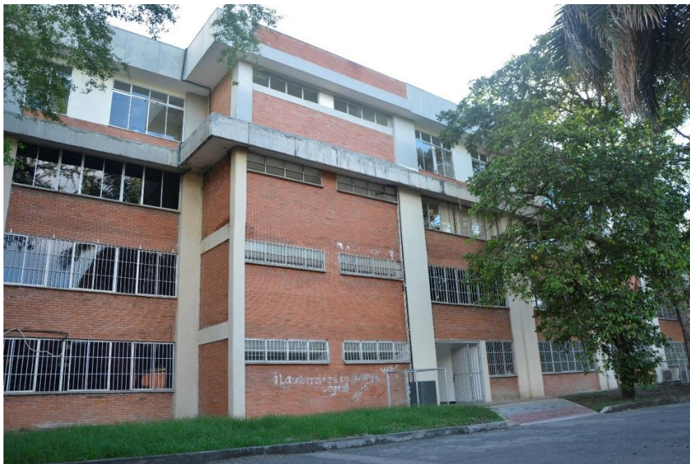
Figura 9. Vista posterior del Edificio 50.
