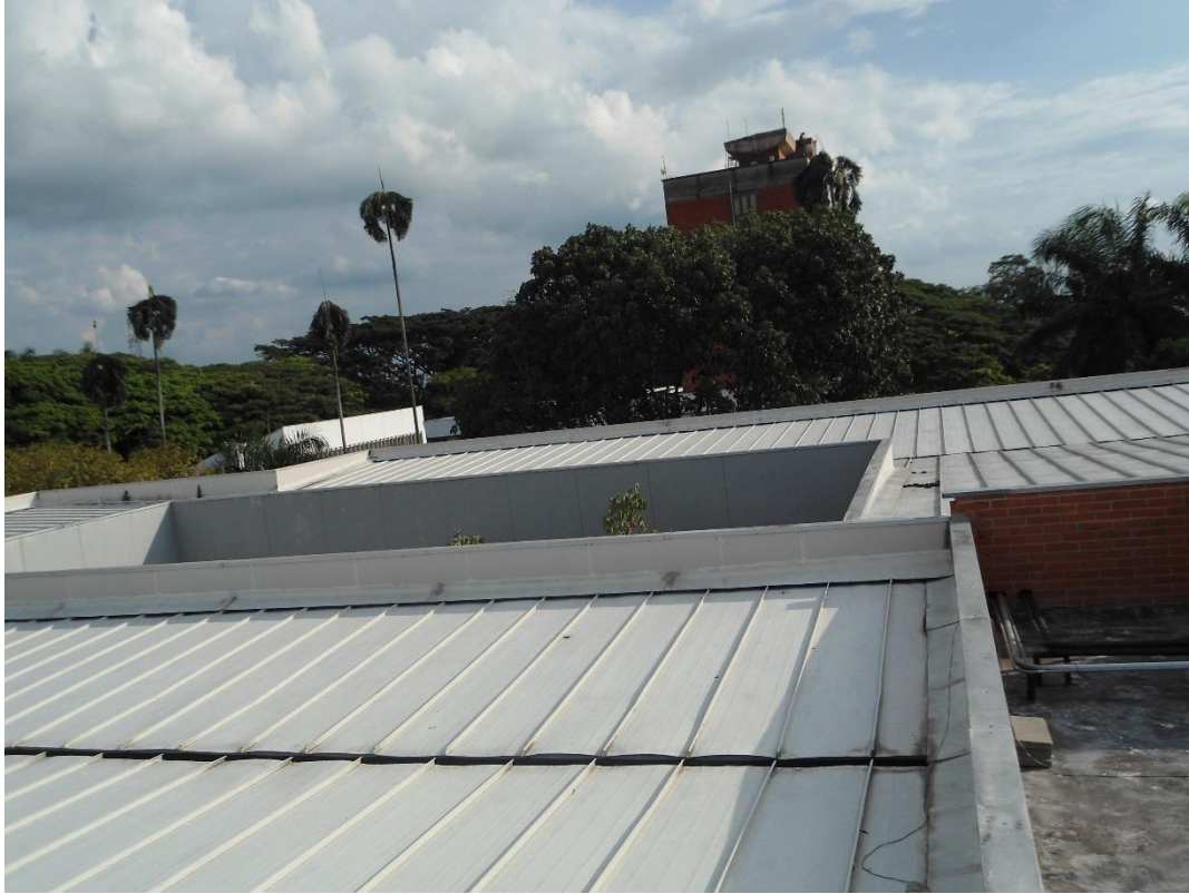
Figura 10. Vista parcial de la cubierta del Edificio 50.
