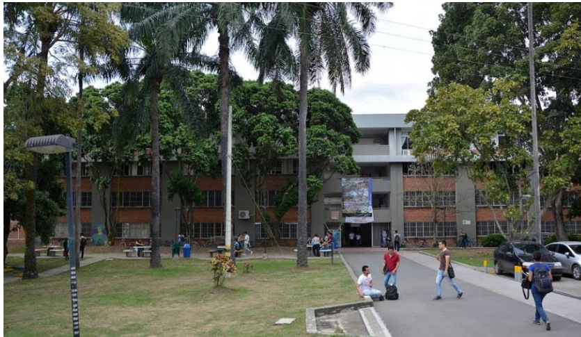
Figura 6. Vista frontal del Edificio 50
