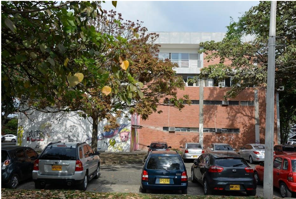
Figura 8. Vista lateral izquierda del Edificio 50.
