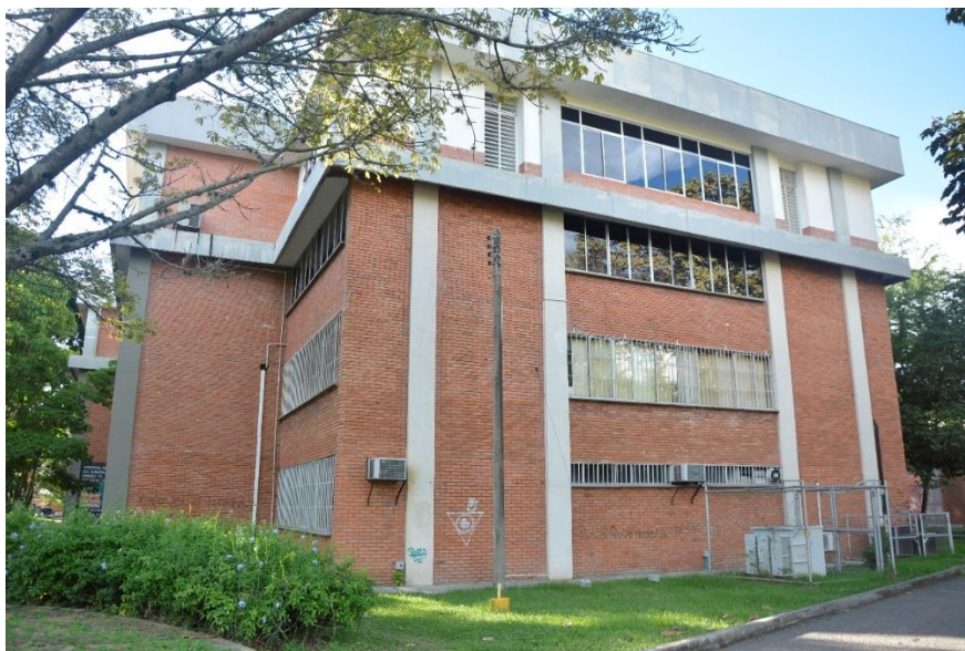
Figura 7. Vista lateral derecha del Edificio 50.
