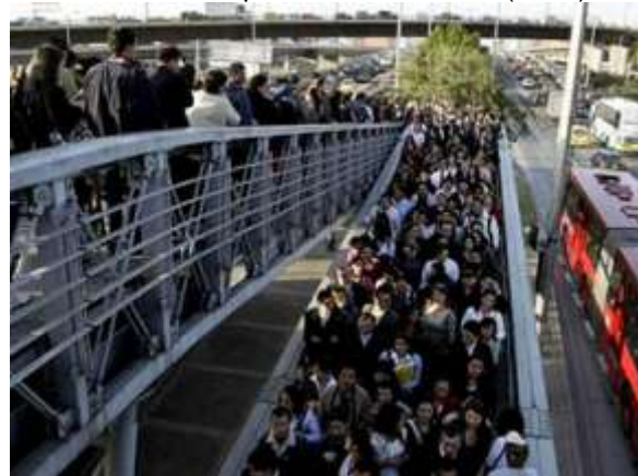
Fotografía 3-34. Troncal Autopista Norte estación Calle 100, Bogotá DC Fuente: www.portalcolombia.com (2010)
