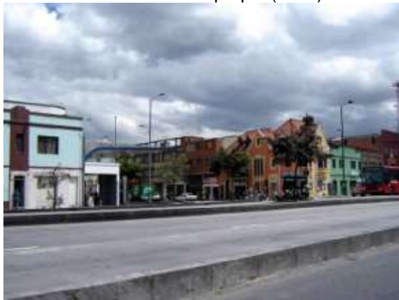
Fotografía 3-16. Troncal Avenida Caracas barrio Santa Fe Fuente: Archivo propio (2005)
