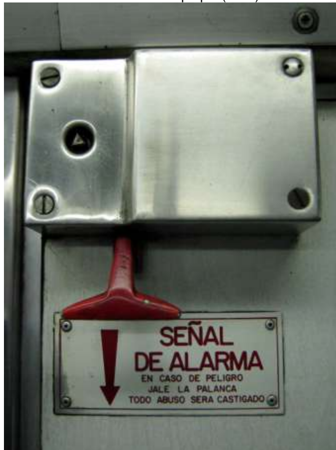
Fotografía 2-5. Mecanismo de señal de alarma en un vagón del metro de México DF Fuente: Archivo propio (2010)
