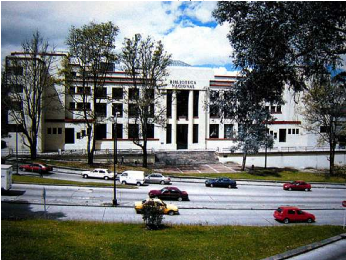
Fotografía 2-4. Efecto barrera por proyectos de infraestructura vial Calle 26 entre Parque de La Independencia y Biblioteca Nacional. Bogotá DC Fuente: Archivo propio (2006)
