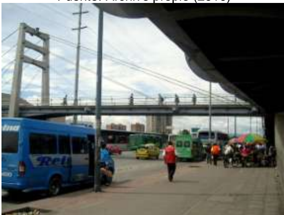
Fotografía 3-38. Portal Norte TransMilenio año 2010, Bogotá DC Fuente: Archivo propio (2010)
