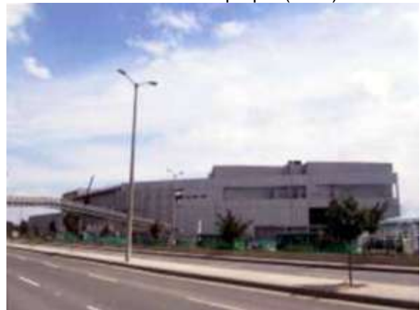
Fotografía 3-28. Portal Calle 80 año 2011 Fuente: Archivo propio (2011)
