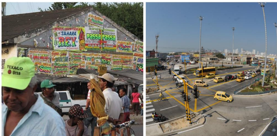
Figura 6. Entrada en sentido sur- norte al mercado de Bazurto antes y después de la construcción del tramo del sistema masivo de transporte público Transcaribe.
