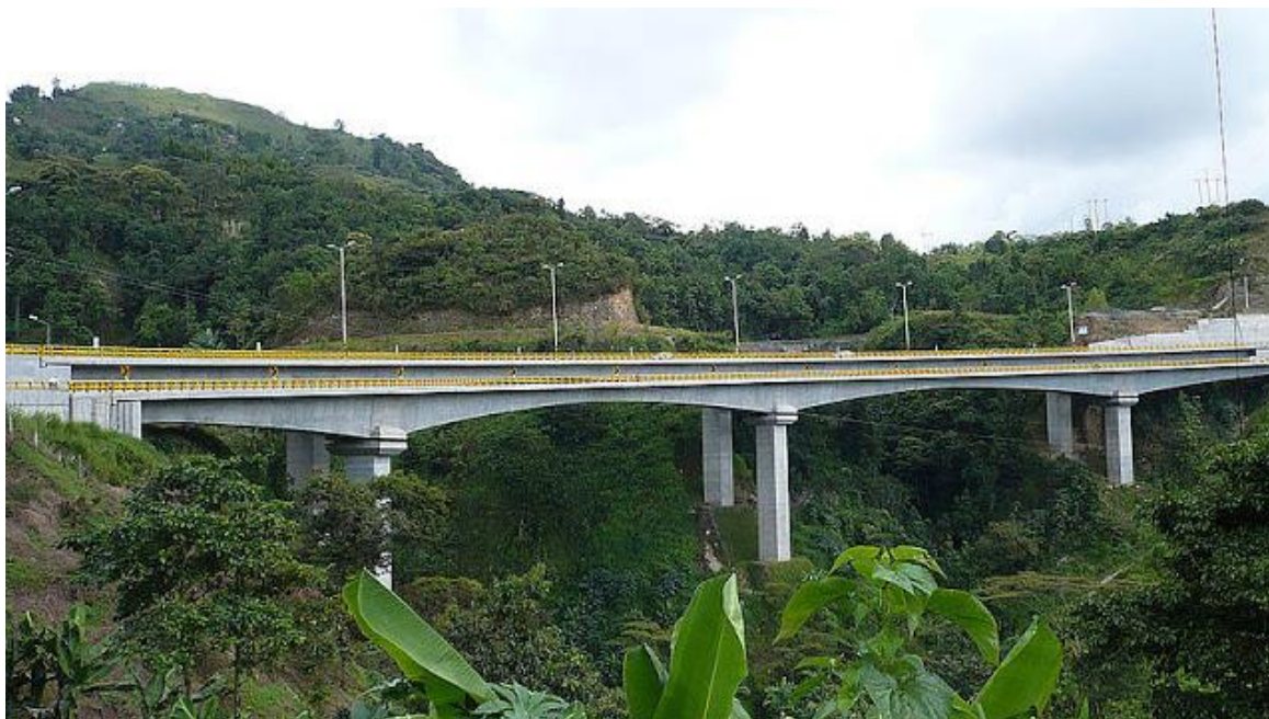
Viaducto de La Estampilla, construido por Gregorio Rentería, ingeniero egresado de la UN y reconocido con el Premio Nacional de Ingeniería que otorga la Sociedad Colombiana de Ingenieros. foto: archivo particular
