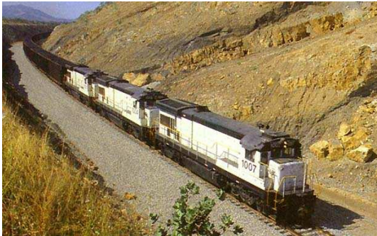
Ilustración 2. Construcción de la vía Férrea. 3
