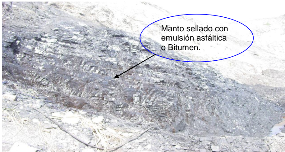
Ilustración 19. Incendio manto 75 sellado con Bitumen.
