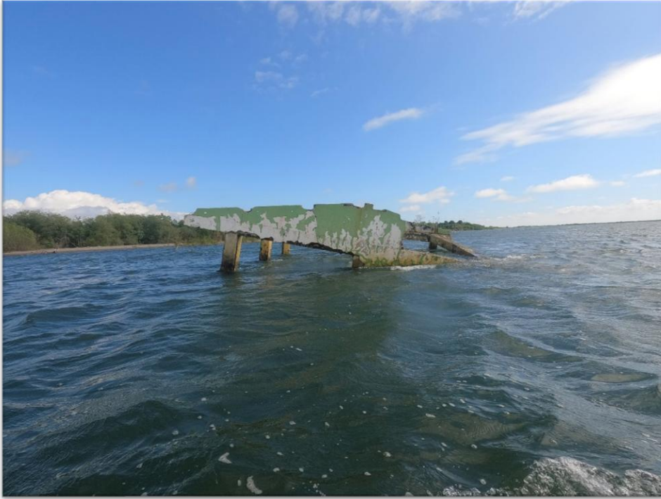
Figura 3. Evidencia de erosión costera en la zona Bocagrande en el municipio de Tumaco, al fondo, el bosque de manglar tras una barra de arena.
