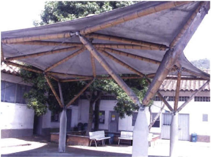
Figura 44. Estructura espacial en guadua existente en la Universidad Nacional de Colombia Sede Medellín, desarrollada por Obermann & Laude (2004) Foto. Eugenia González C. 2009
