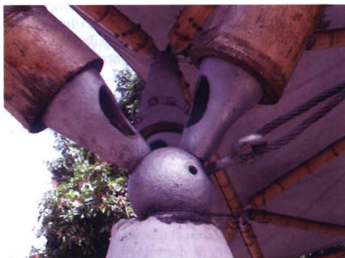
Figura 42. Detalle de uniones con tornillos
