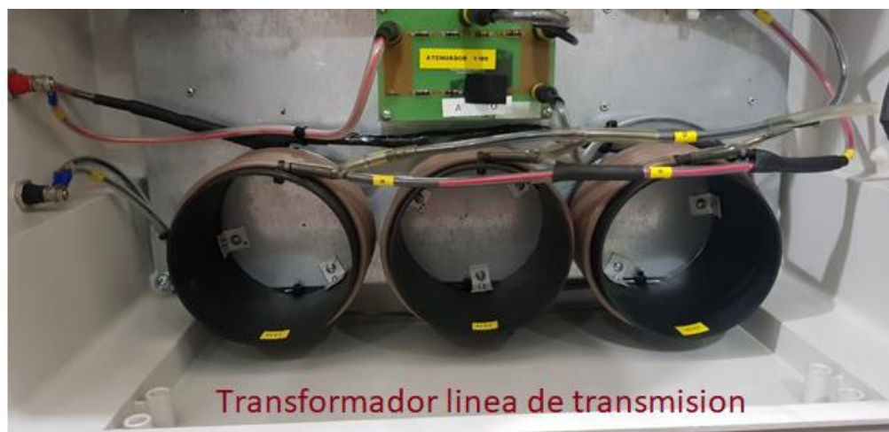
Figura 3-9: Disposición física del TLT en el generador de pulsos.
