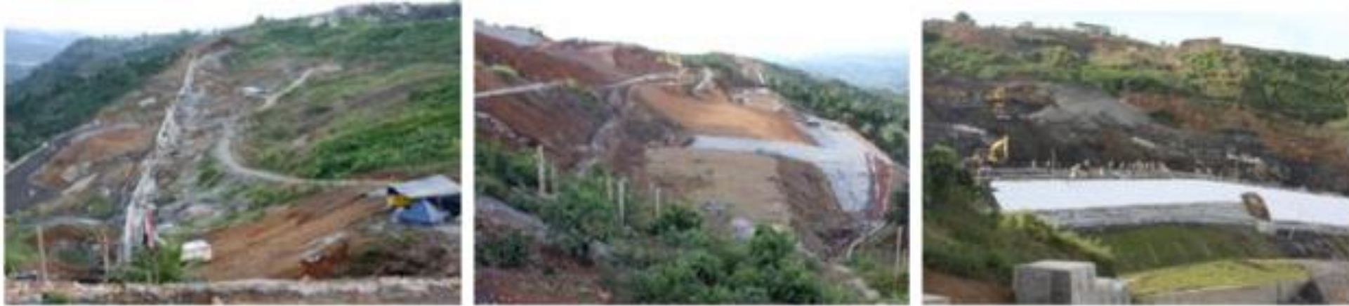
Imagen 6. Secuencia de los Terraplenes 8, 9 y 10. En La Patria.com
