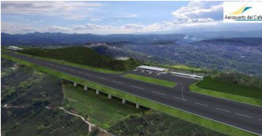
Imagen: Pista con estructura de concreto en lugar del Terraplén 8. Imagen de Aerocafé.
