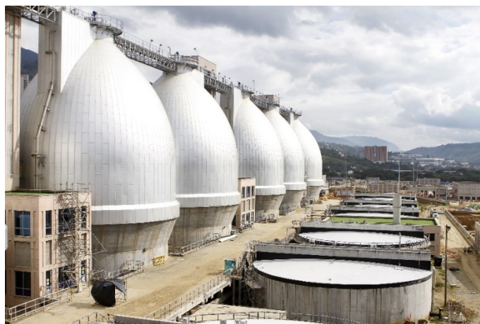
Figura 27 Digestor anaerobio
