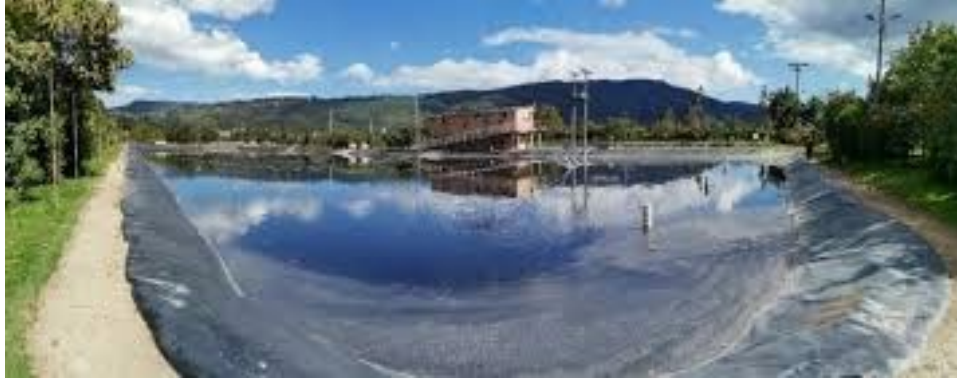
Figura 11 Laguna anaerobia - PTAR de chía
