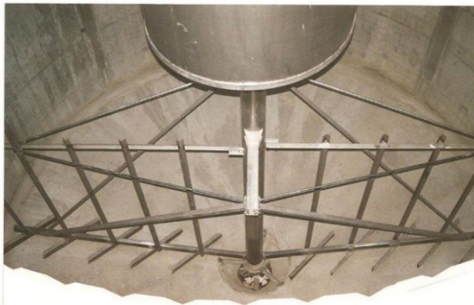
Figura 26 Espesador gravitacional
