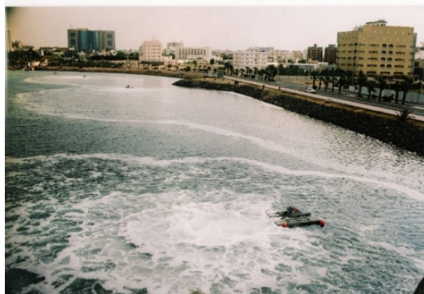
Figura 13 Inyección de aire en sistemas lagunares
