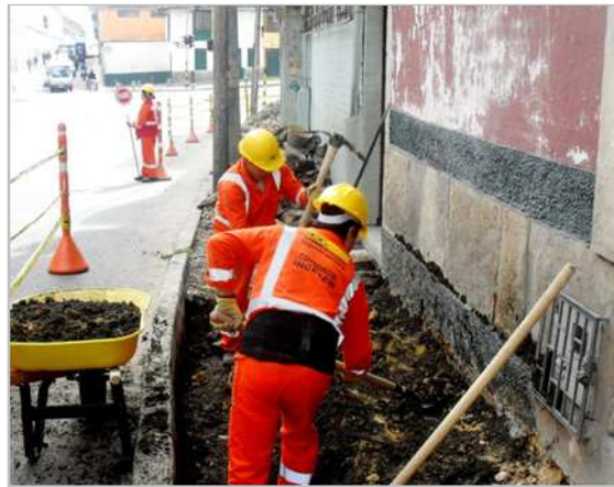
Figura 4-9: Mantenimiento de andenes en el barrio Santa Bárbara (Alcaldía Menor de La Candelaria, Junio de 2011).
