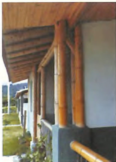
Figura 1.30. Viviendas de un piso: Bahareque encementado, Barcelona – Quindío
