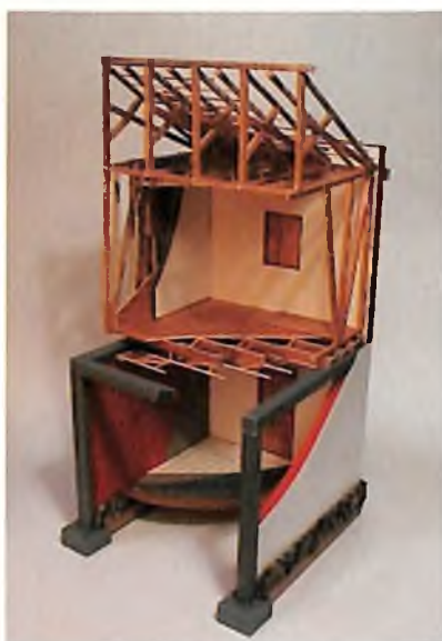
Figura 1.23. Fachada en mampostería de ladrillo – Pórticos de concreto – Mampostería de ladrillo 1º piso y Bahareque 2º piso.
