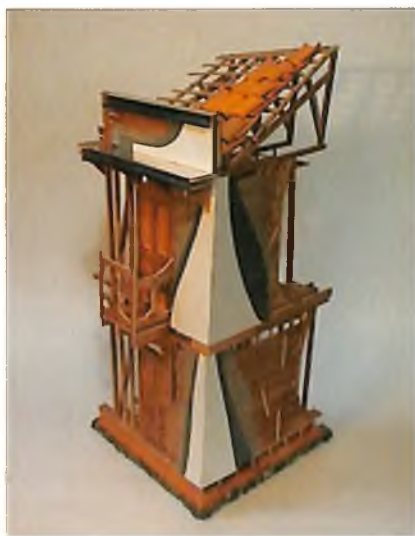
Figura 1.101. Bahareque encementado - marcos estructurales en madera
