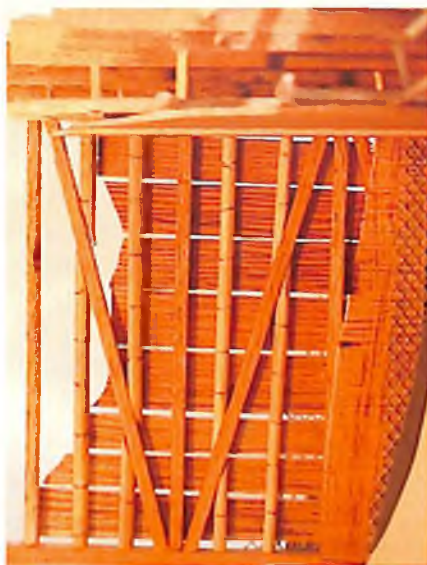
Figura 1.14. Bahareque Encementado: Marcos estructurales de madera y paralelos verticales o suplefaltas en guadua.
