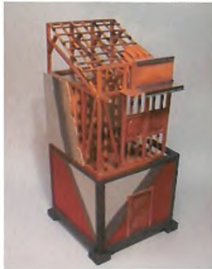
Figura 1.26. Pórticos de concreto - Fachada y mampostería de ladrillo 1º piso - Fachada y bahareque 2º piso.
