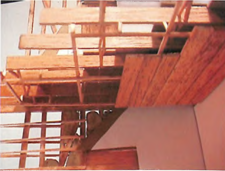
Figura 1.49. Entrepiso ó diafragma 2º piso con cieloraso en madera
