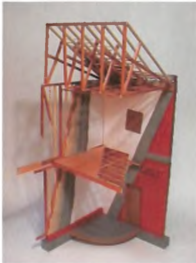
Figura 1.22. Fachada en mampostería de ladrillo y bahareque 1º y 2º piso.
