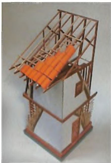
Figura 1.16. Marcos estructurales en madera
