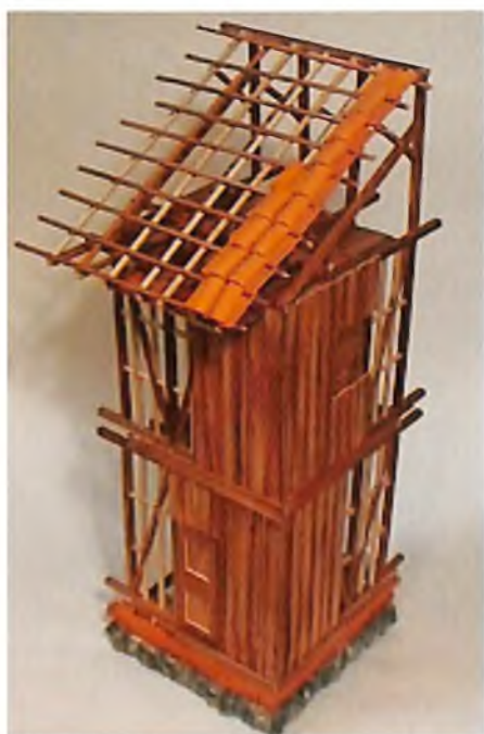
Figura 1.84. Marcos estructurales en madera
