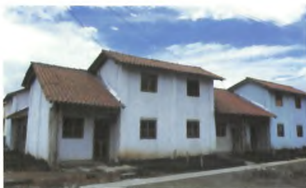
Figura 1.29. Viviendas de dos pisos: Bahareque encementado, Barcelona – Quindío
