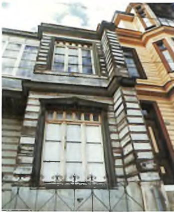
Figura 1.7. Vivienda Marburg – Alemania Entramados en Madera
