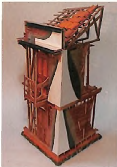
Figura 1.20. Bahareque encementado
