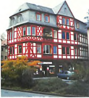
Figura 1.5. Vivienda Marburg – Alemania Entramados en Madera
