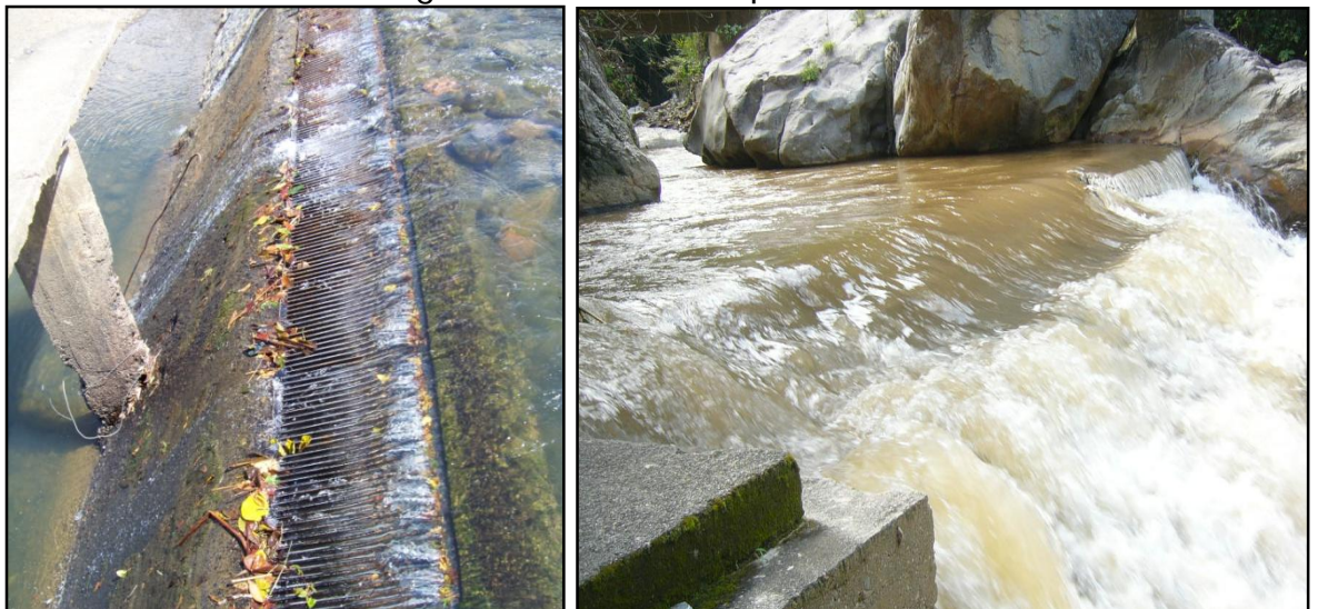
Figura 2.1 Bocatoma tipo Tirol
