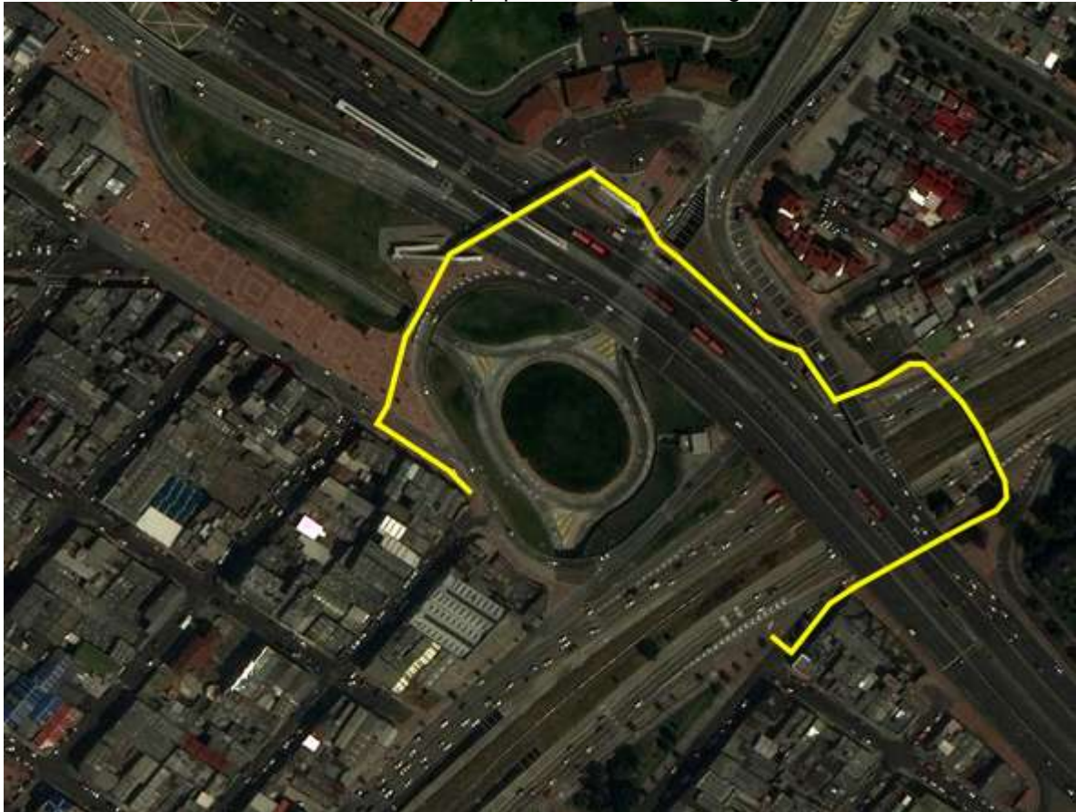
Figura 4-12. Movimiento peatonal Intercambiador Calle 80, NQS, Avenida Suba Fuente: Elaboración propia con base en Google Earth
