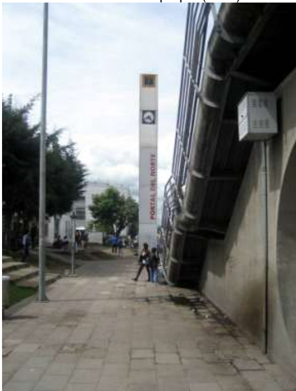
Fotografía 3-46. Portal Norte TransMilenio año 2010, Bogotá DC Fuente: Archivo propio (2010)
