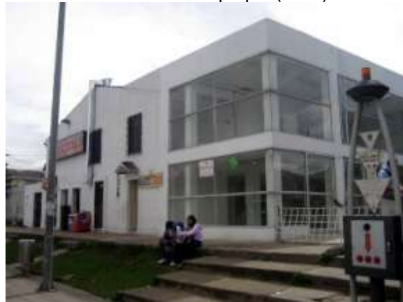
Fotografía 3-49. Portal Norte TransMilenio año 2010, Bogotá DC Fuente: Archivo propio (2010)
